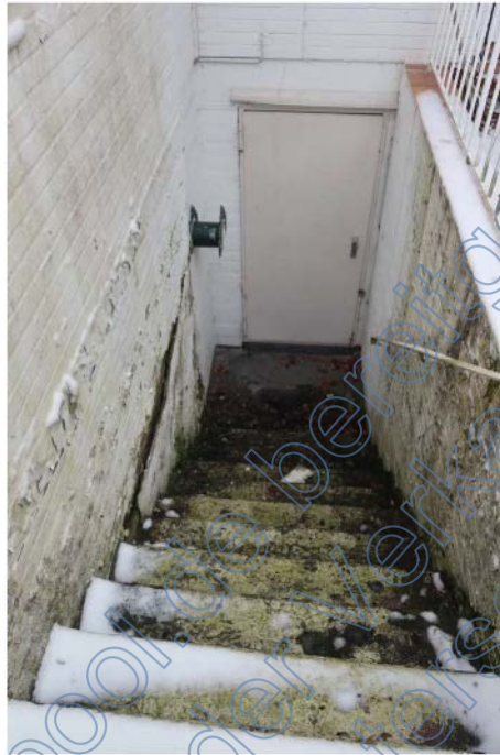
Kelleraußentreppe an Trennwand zum Nachbarn
