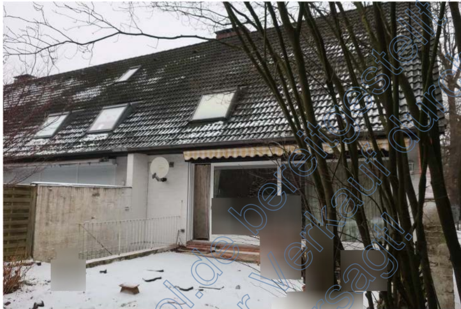
Rückansicht mit Blick zur Nachbartenwand Blick Richtung Nordwesten
