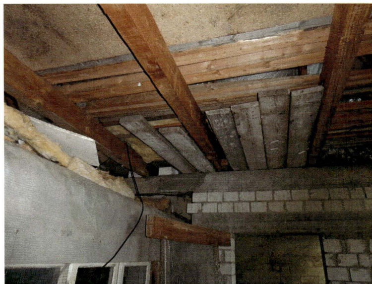
Bild 44: Decke zum Dachgeschoss
