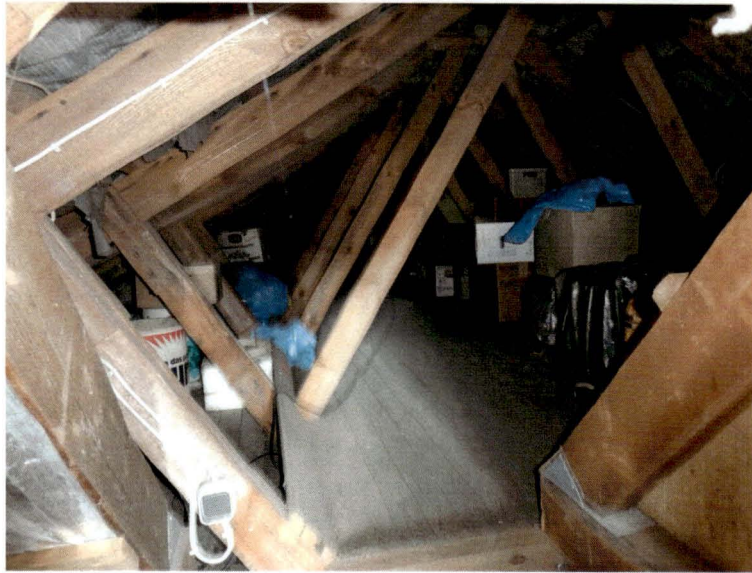
Bild 52: nicht ausbaubarer Bereich
