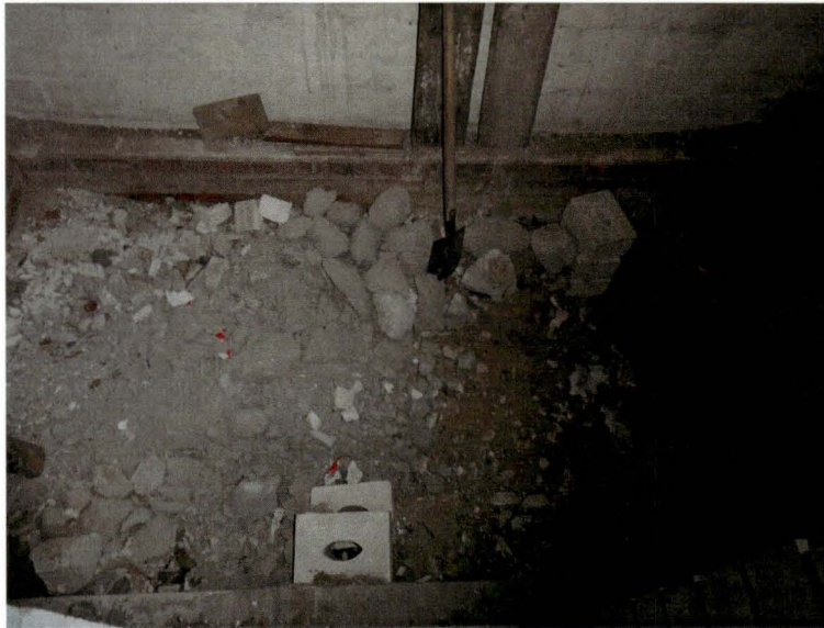
Bild 46: unvollständiger Fußbodenaufbau
