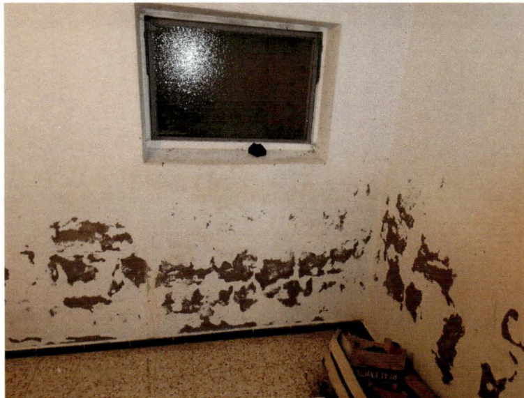
Bild 40: Keller / Feuchtigkeitsschäden
