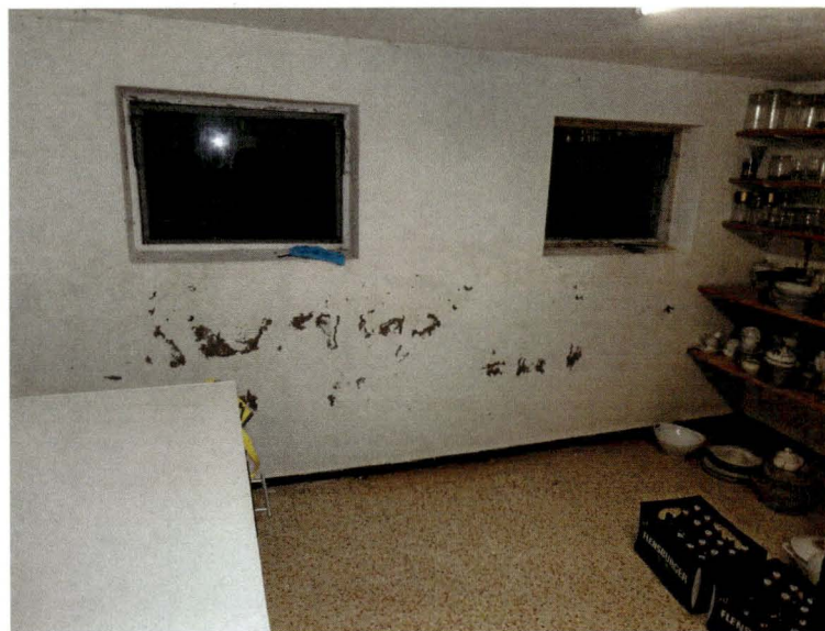
Bild 41: Keller / Feuchtigkeitsschäden
