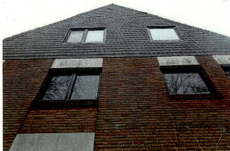
Bild 6: Giebel der Nordwestansicht
