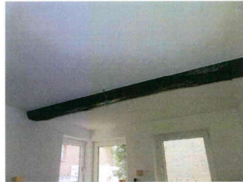
Deckenbalken Zimmer / Anbau gartenseitig
