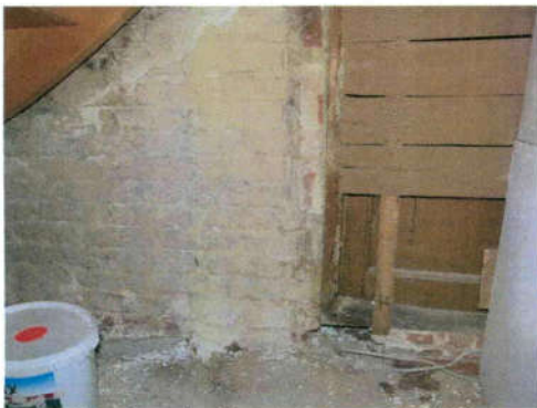
Abseite unter Geschosstreppe EG-OG
