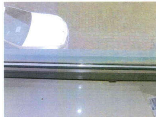
Verglasung Fenster straßerseitig
