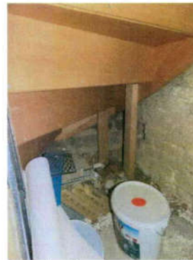
Abseite unter Geschosstreppe EG-OG
