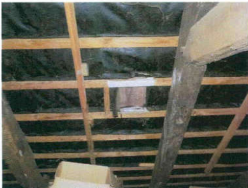
Dachboden / Deckung in Papdocken
