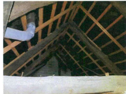
Dachboden / Deckung in Pappdcken
