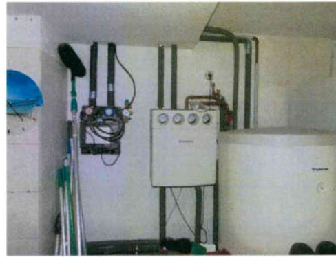
Solarthermie / Warmwasserspeicher
