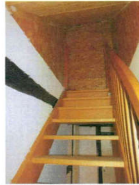
Treppe zum Dachraum / Dachboden
