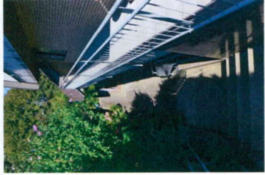
Bild 7 Außentreppe an westl. Giebelseite vom Erd- zum Untergeschoss
