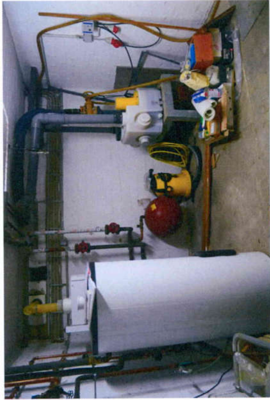
Bild 9 Heizraum mit Warmwasserspeicher und Hebeanlage für Abwasser
