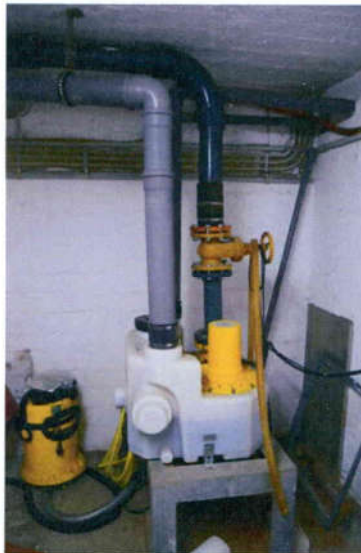
Besondere Bauteile: - Kelleraußeneingang – ohne Foto
