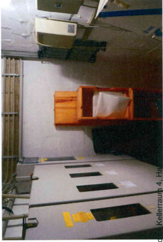
Bild 9 Heizraum mit Warmwasserspeicher und Hebeanlage für Abwasser
