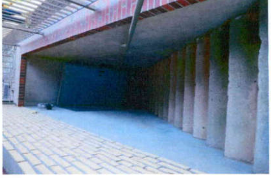
Bild 8 Außentreppe zum Kellergeschoss Anlage 1 Bilder des Objektes - außen
