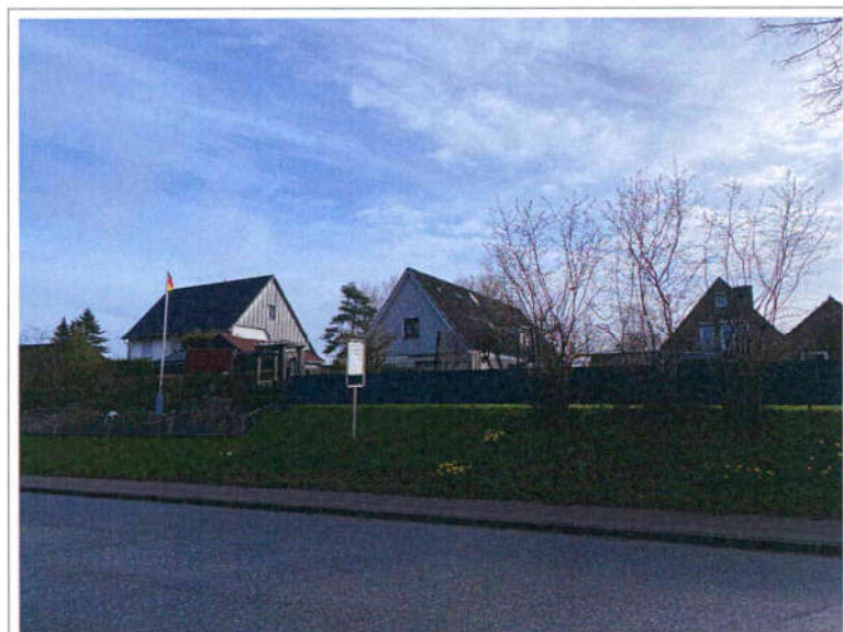
Foto 3: Ansicht von der Straße
