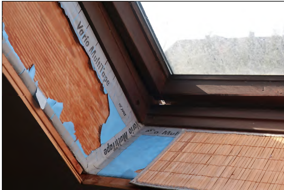
Detailansicht Bad DG
