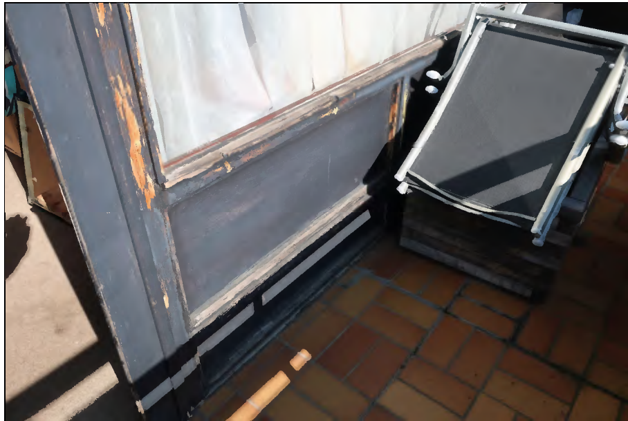
Detailansicht Fenster DG Südseite
