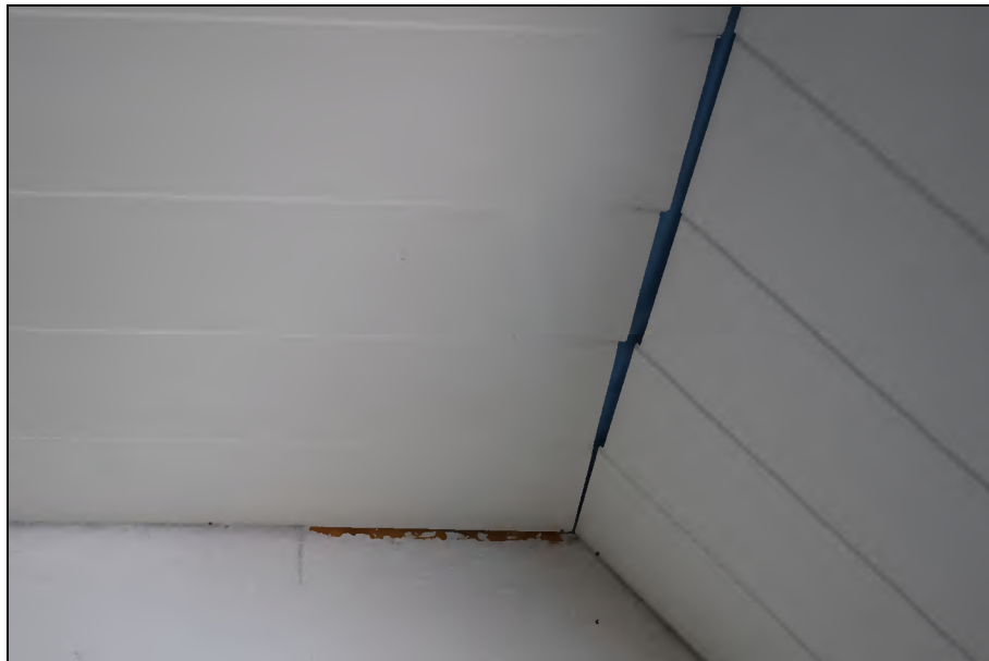
Detailansicht Bad DG
