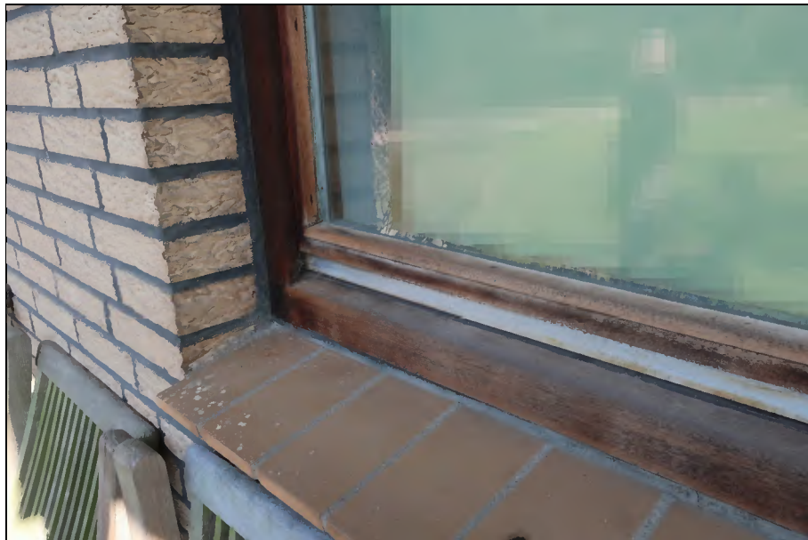
Detailansicht Fenster EG
