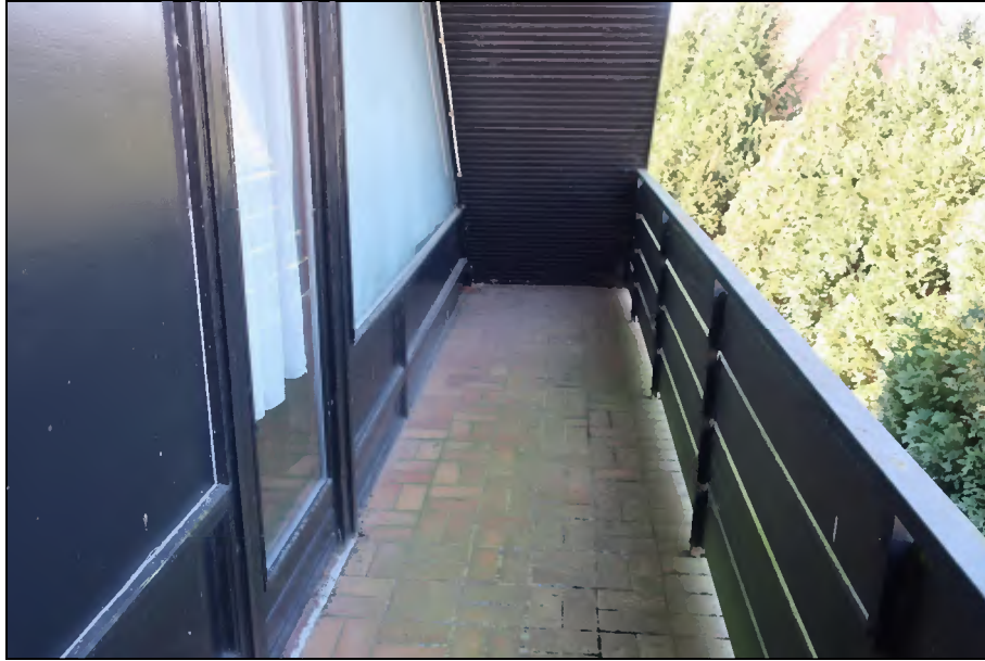
Balkon DG Nordseite
