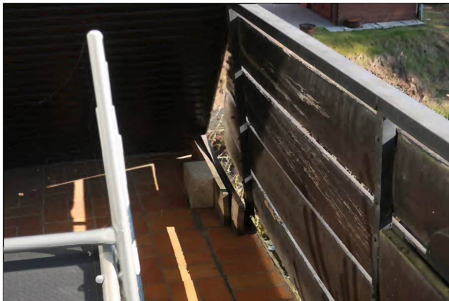
Detailansicht Balkon DG Südseite
