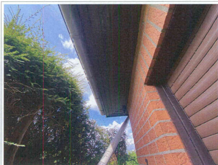
Foto 12: Dachunterschläge
