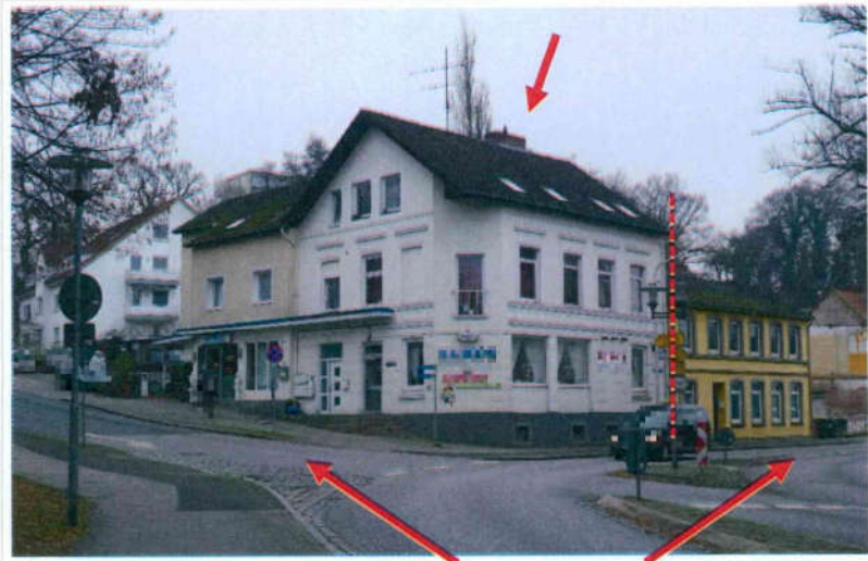
Bild 1: Lage im Kreuzungsbereich Jägerstraße - Schweriner Straße
