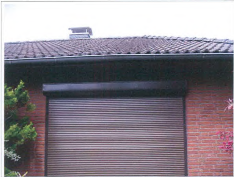
Foto 53: Wohnhaus, Südfassade und Dachfläche
