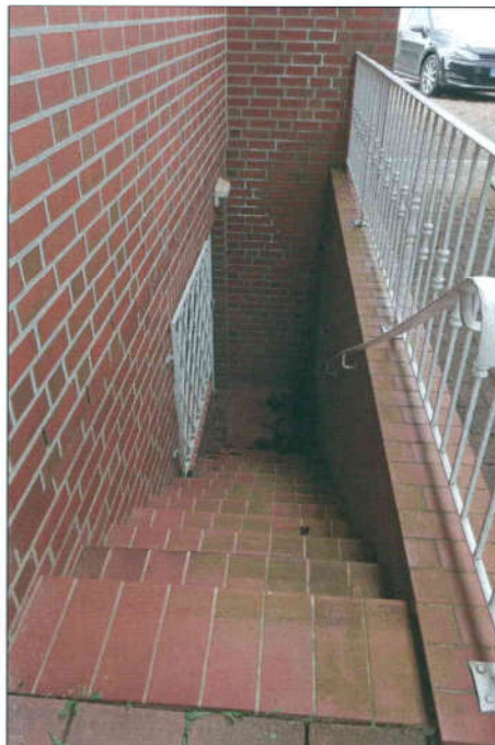
Partiell Verfärbungen bzw. ausgebesserte Fugen über der Treppe
