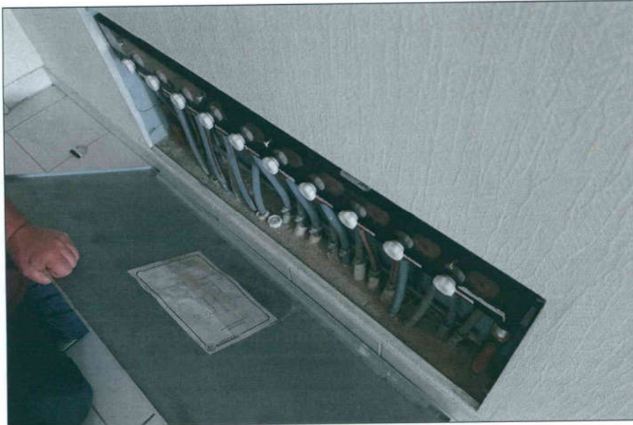
Verteilung Fußbodenheizung
