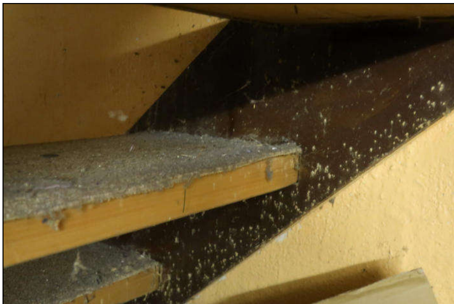
Detailansicht Treppe KG
