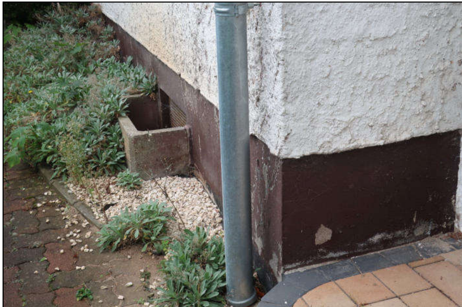
Detailansicht Sockel / Eingangsfassade
