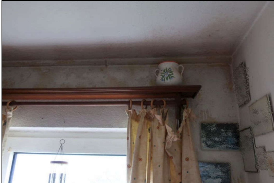
Detailansicht Abstellraum OG (ehem. Küche)
