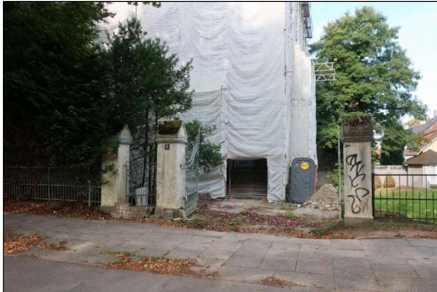
Straßenansicht Bewertungsobjekt mit Grundstückszufahrt
