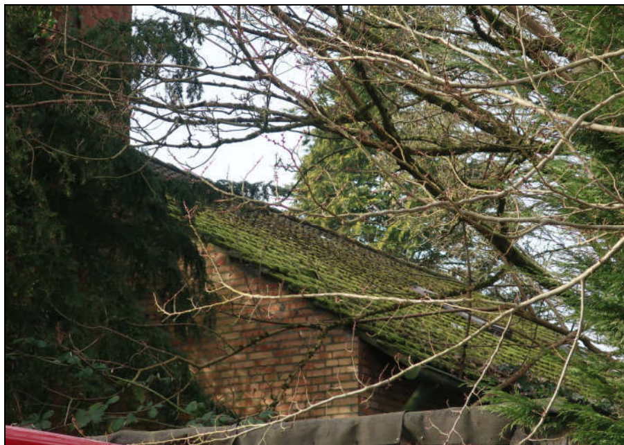
Detailansicht Zustand Dacheindeckung
