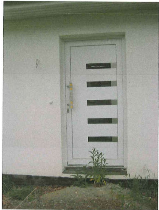
09: Hauseingangstür auf der Nordseite
