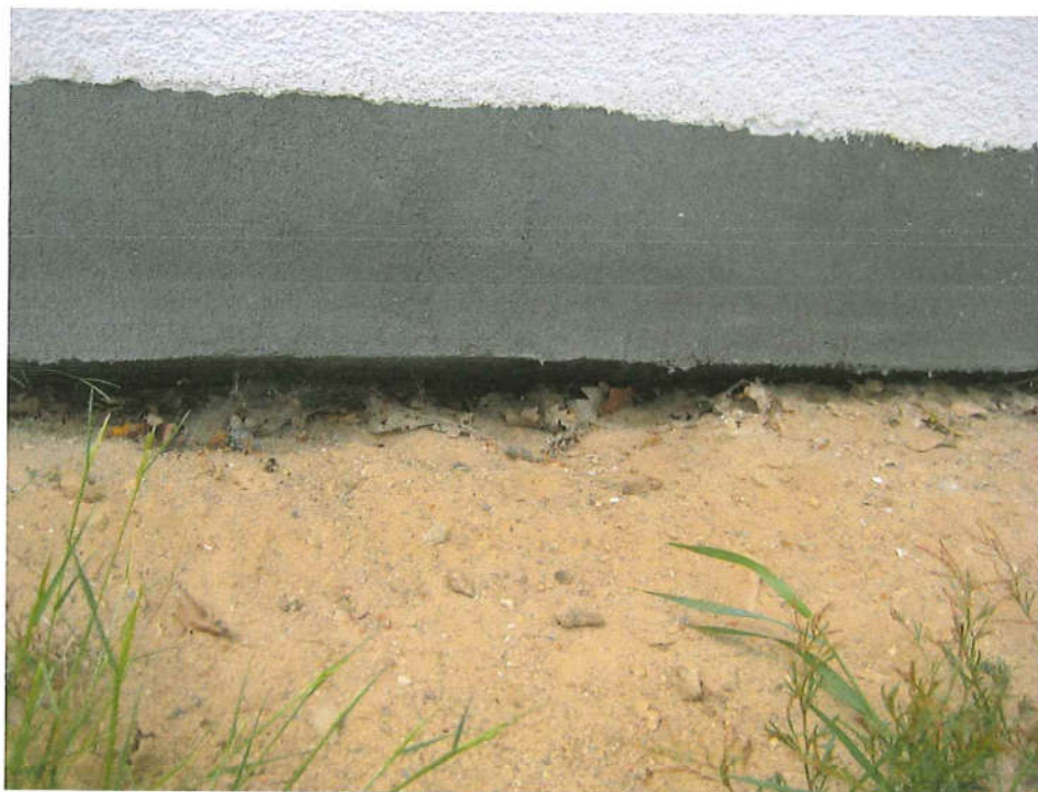
15: Sockel mit WDVS und Dichtanstrich
