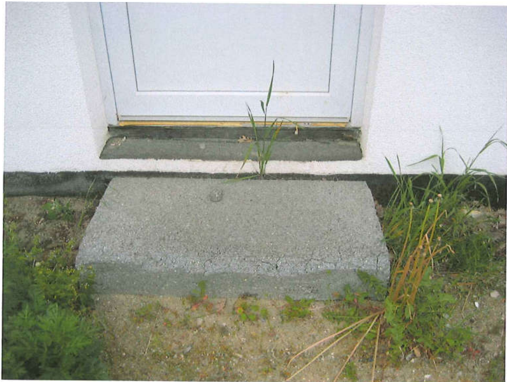
07: Schwelle Nebeneingangstür mit WDVS und Dichtanstrich
