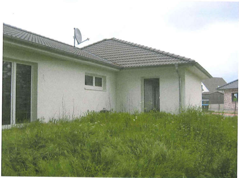
13: Südwestliche Gebäudenische mit Fenstertür Arbeitszimmer
