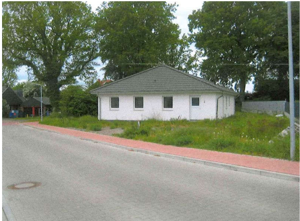
04: Ostseite / Straßenseite mit der Straße Kiebitzring im Vordergrund
