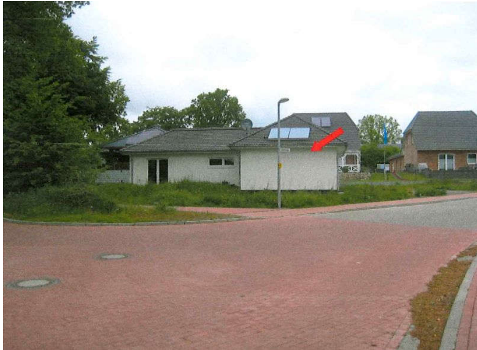
01: Südseite mit Einmündungsbereich der Alten Landstraße in die Straße Kiebitzring (Pfeil zeigt Bewertungsobjekt)
