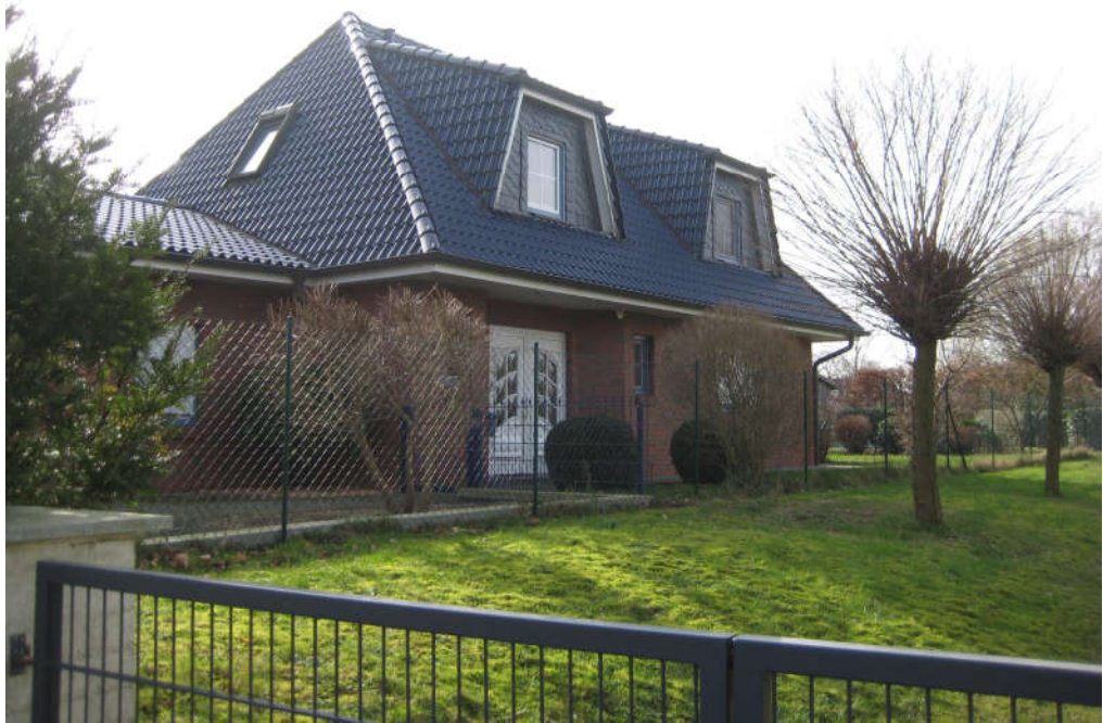
07: Nordwestseite mit Hauseingang
