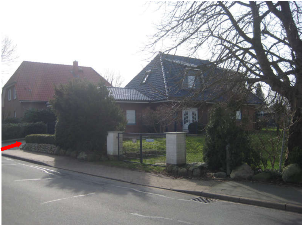
06: Nordwestseite (Pfeil zeigt Zufahrt zur Garage)
