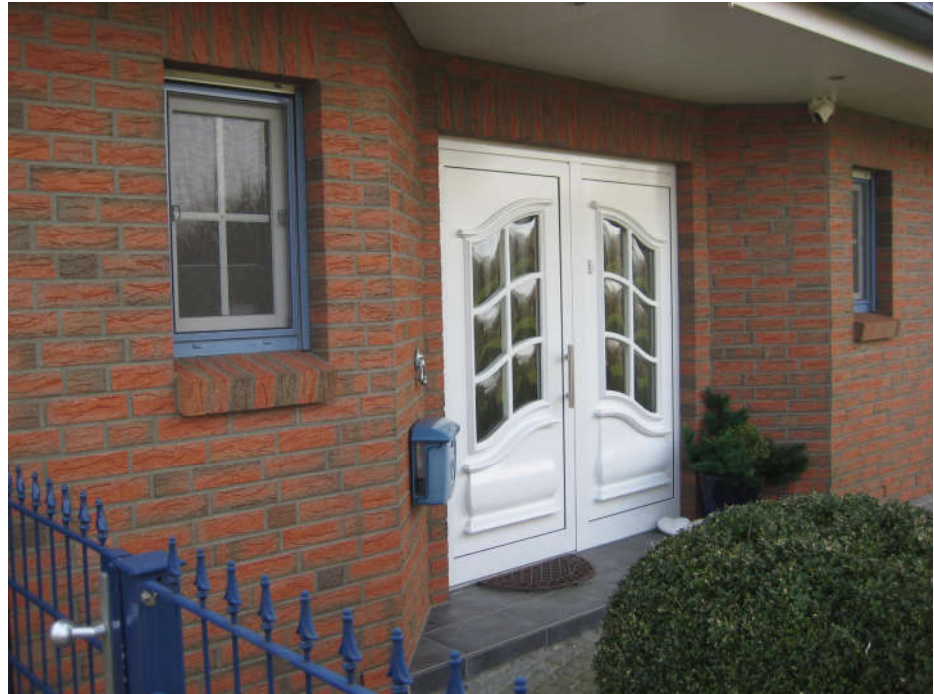
12: Nordwestseite mit überdachtem Hauseingang
