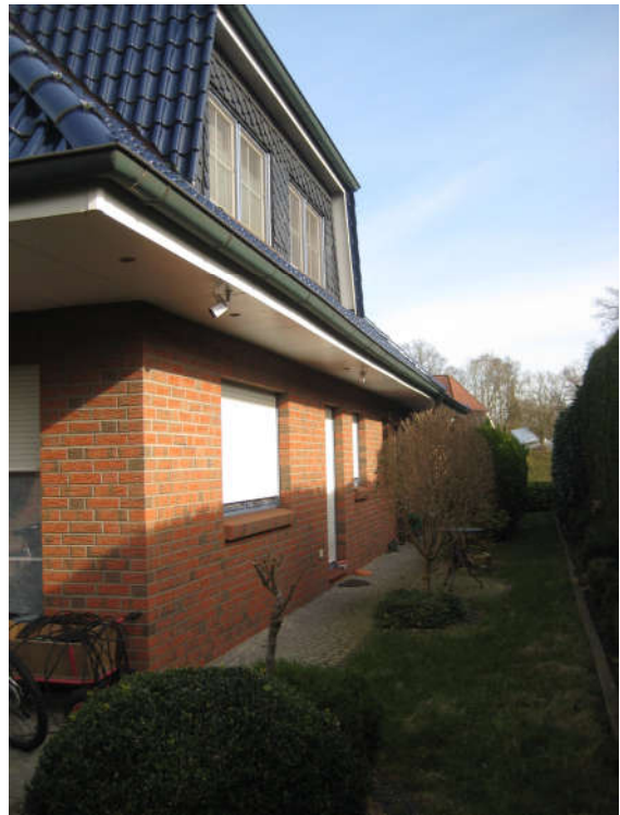
17: Südostseite mit Fenstertür zur Küche
