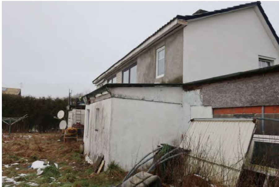
Rückansicht- / Giebelansicht mit Anbau und Garage (rechts)
