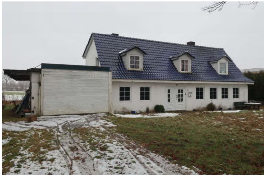
Eingangsansicht mit Garage
