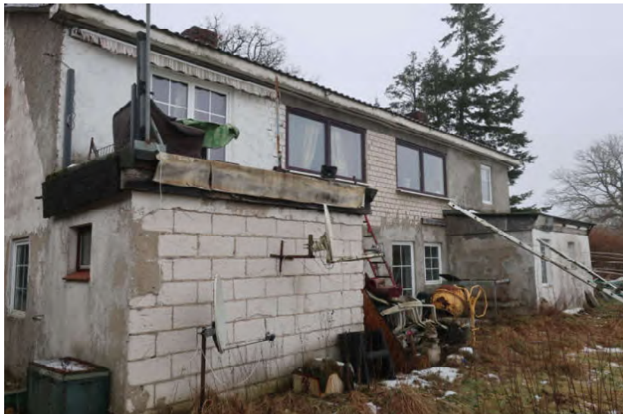
Rückansicht mit rückwärtigen Anbauten
