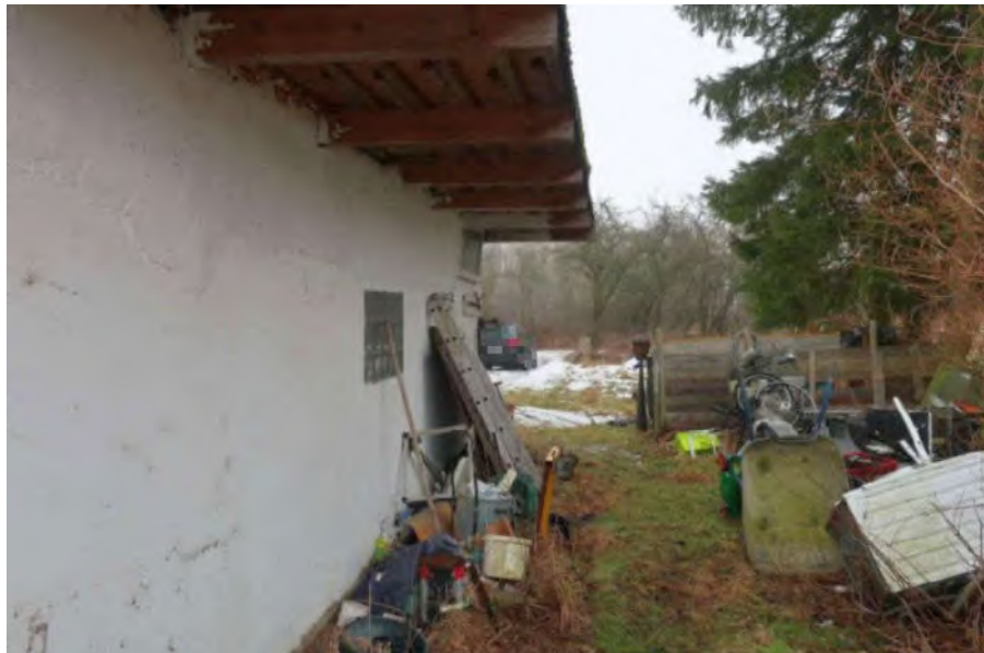
Seitenansicht Garage mit Gerümpel etc. auf dem Bewertungsgrundstück
