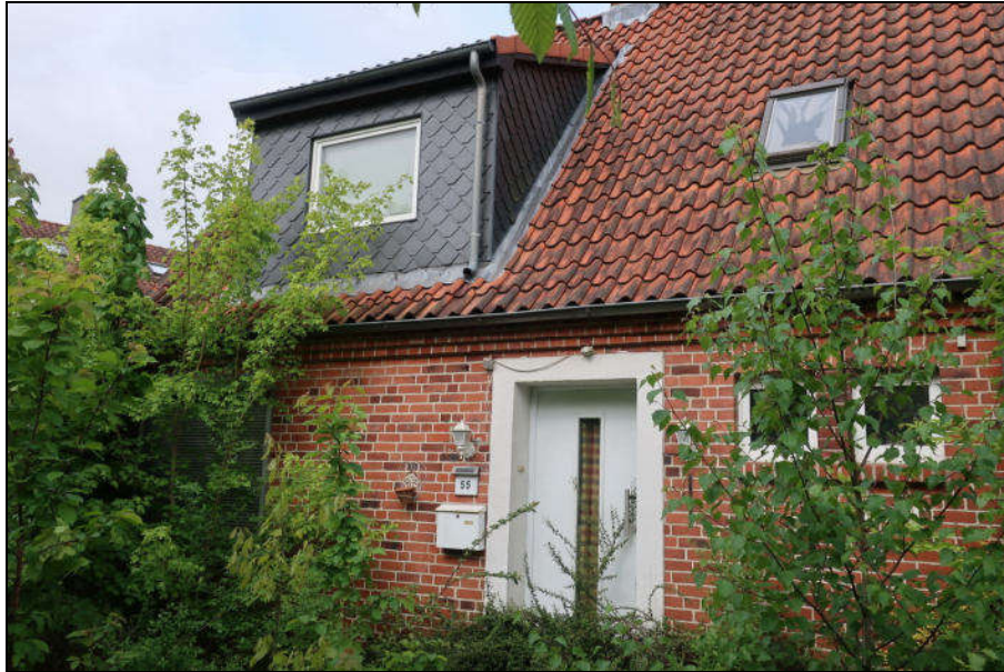
Straßen- /Eingangsansicht Bewertungsobjekt Blick Richtung Südwesten
