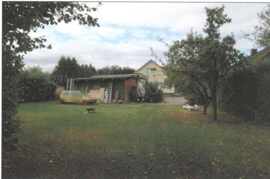
Rückansicht Schuppen und Wohnhaus
