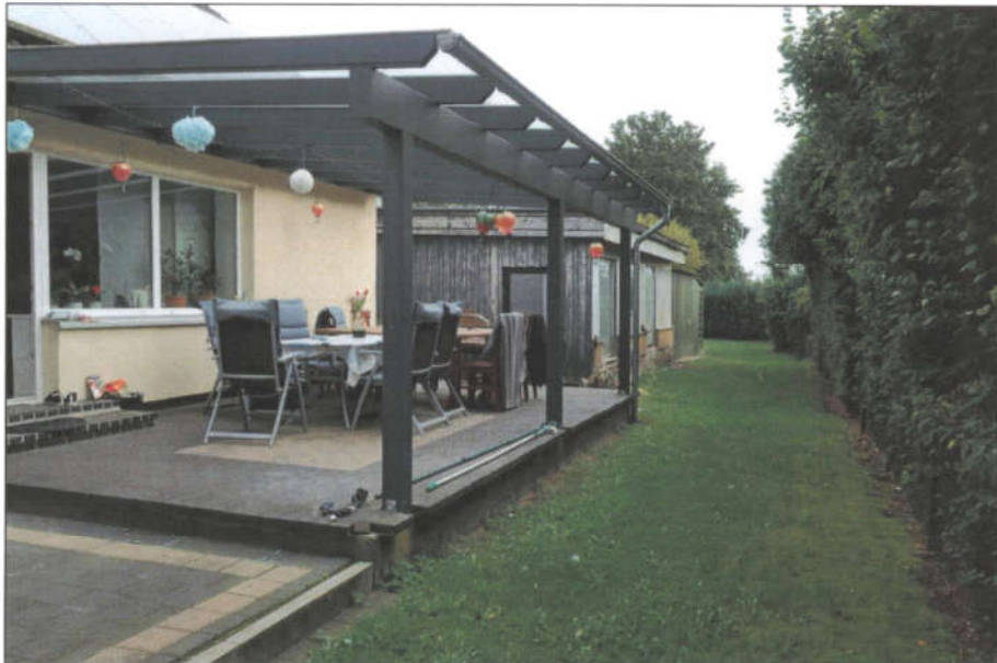
südlicher Grundstücksbereich mit Terrasse
