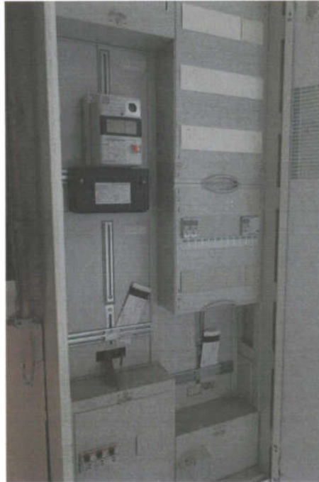
Elektronterverteilung / Zähler
