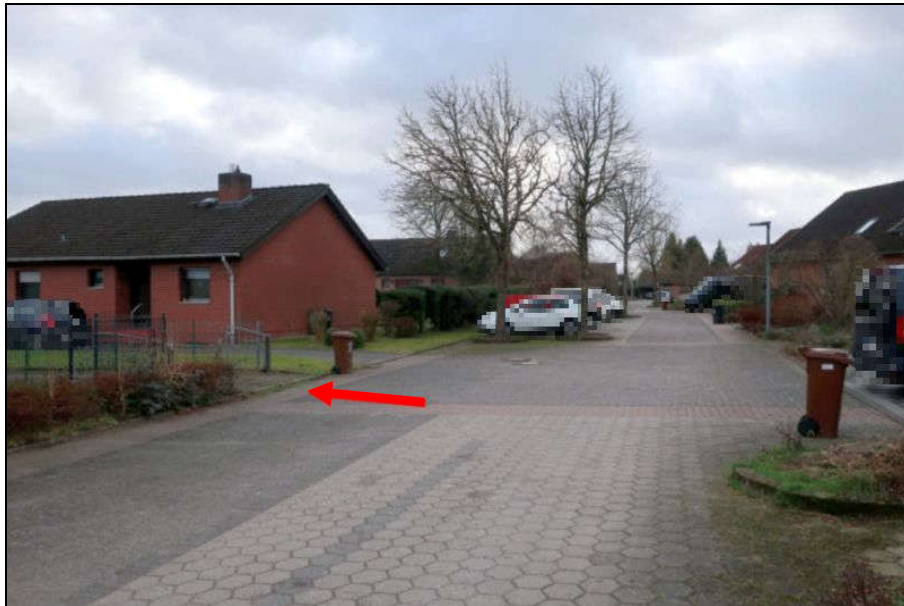
Straßensituation Otto-Flath-Straße mit Zufahrt zum Bewertungsgrundstück
