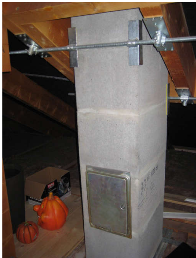
54: Schornstein mit Revisionsöffnung
