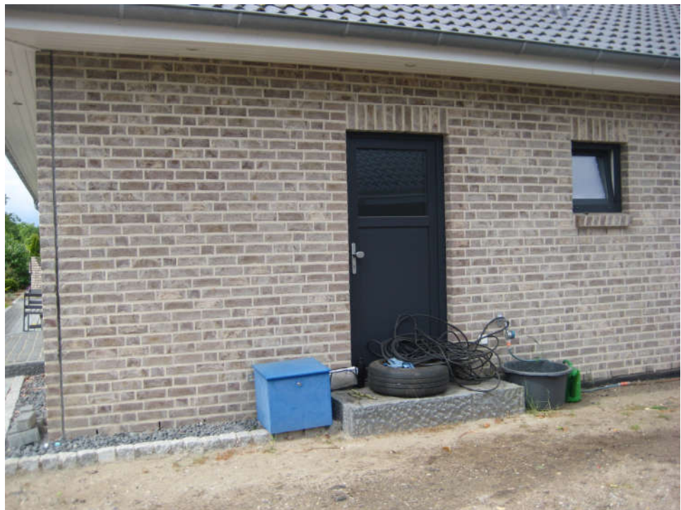
23: Nebeneingangstür zum HWR Nordostseite
