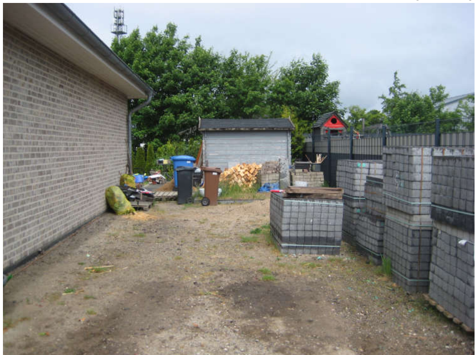
22: unfertige Fläche für Kfz-Stellplätze Nordostseite
