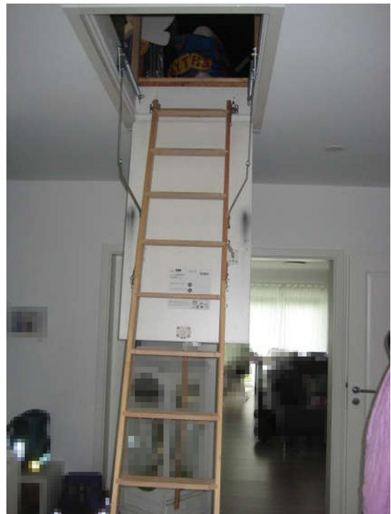
51 und 52: Einschubtreppe zum Dachboden
