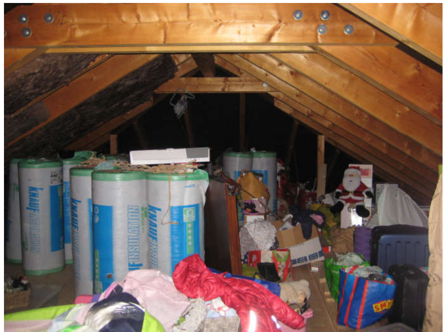
53: Blick in den Dachboden
