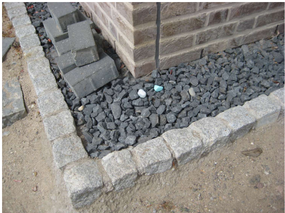
24: umlaufendes Kiesbett mit Granitpflastereinfassung
