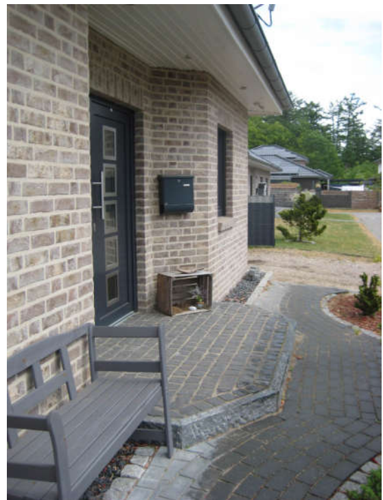
10: Hauseingang mit Podest
