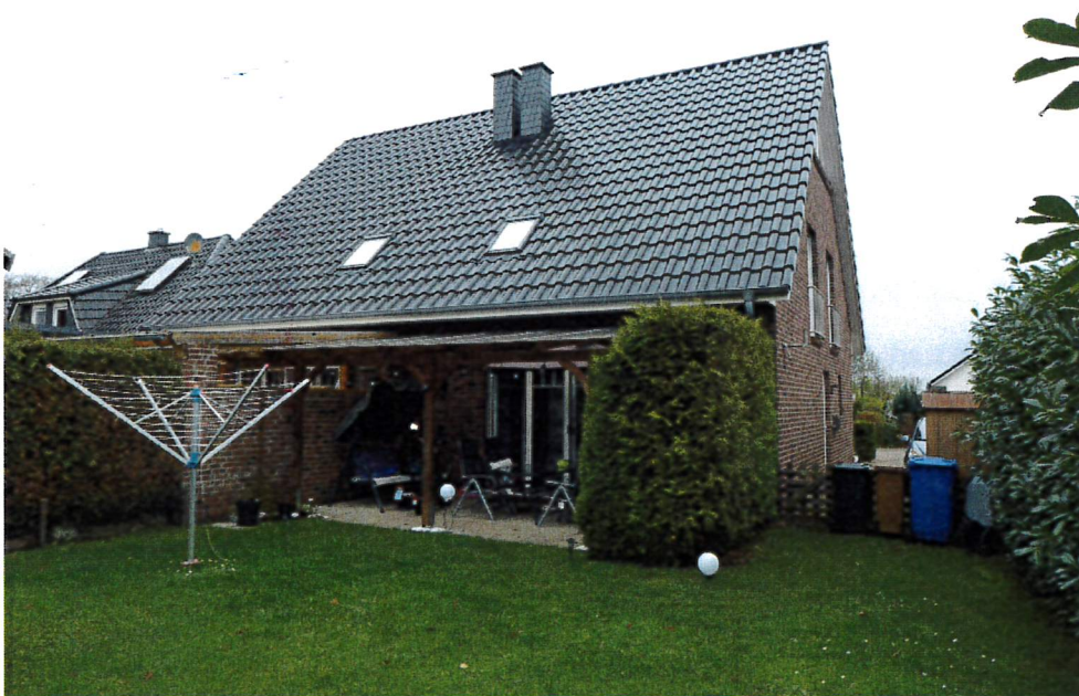
Foto 2: Rückwärtige Ansicht / Garten
