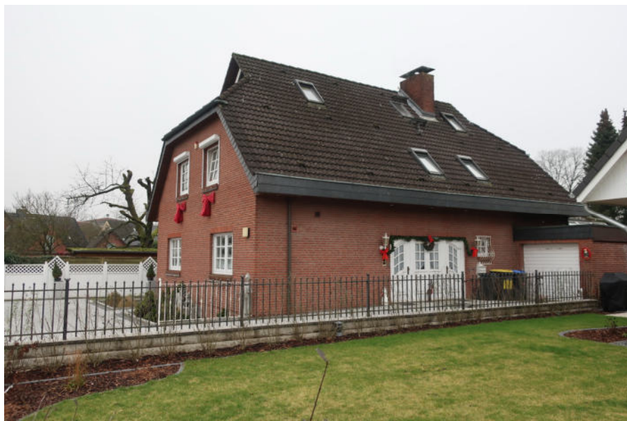
Straßen- und Eingangsansicht Bewertungsobjekt mit Garage
