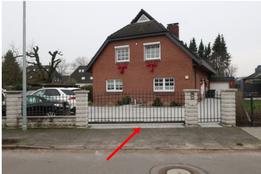
Straßenansicht Bewertungsobjekt mit Zufahrt zur Garage / Stellplatzfläche
