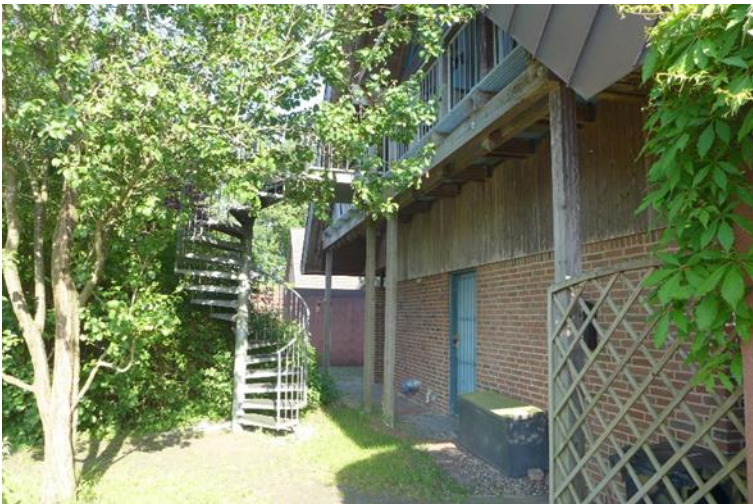
Treppe zur DG-Wohnung
