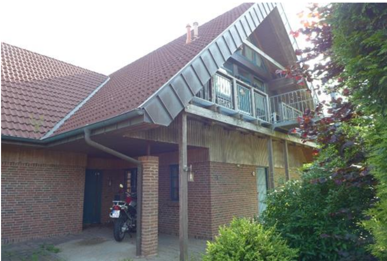
Eingang Wohnung EG
