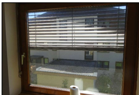
Fenster und Türen: Ausführung in Holz mit 2 – fach Thermo (Originalzustand) 17
