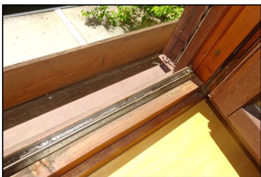
Fenster und Türen: Ausführung in Holz mit 2 – fach Thermo (Originalzustand) 17
