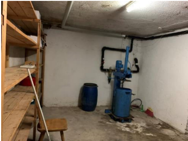
Bild 65 von 88 Blick in einen Kellerraum
