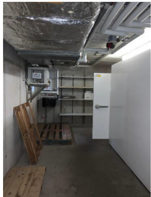
Bild 64 von 88 Blick in den Kellerflur
