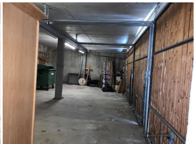
Bild 88 von 88 Blick in den Garagenbereich
