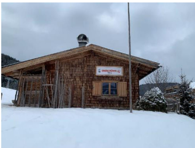
Bild 7 von 88 Ansicht aus Osten
