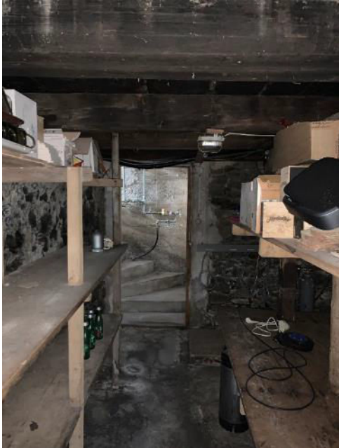
Bild 85 von 88 Blick in den Kellerraum
