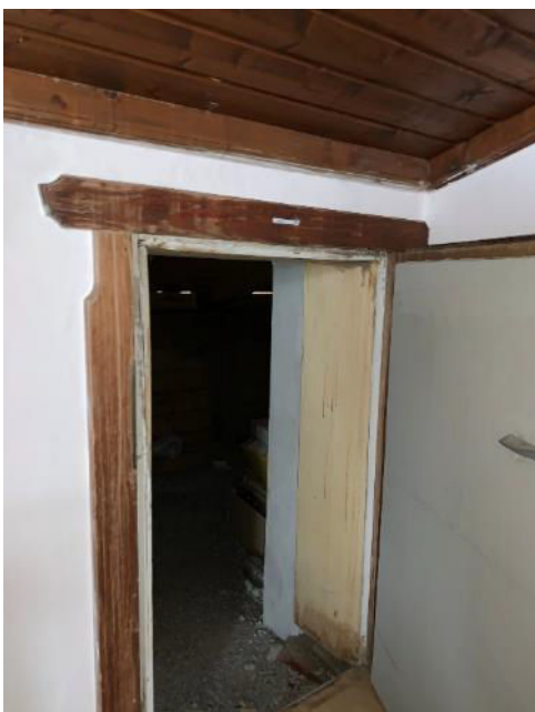
Bild 23 von 88 Blick auf den Zugang zum Dachraum
