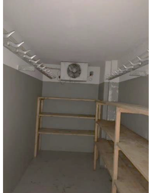
Bild 66 von 88 Blick in eine Kühlzelle
