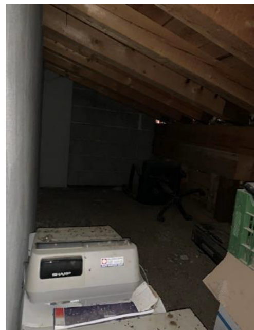
Bild 24 von 88 Blick in den Dachraum
