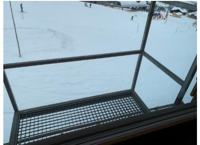
Bild 18 von 88 Blick auf eine Fluchttreppe am Ende des Flurs
