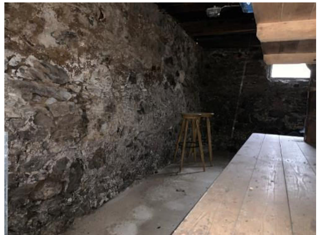
Bild 86 von 88 Weiterer Blick in den Kellerraum
