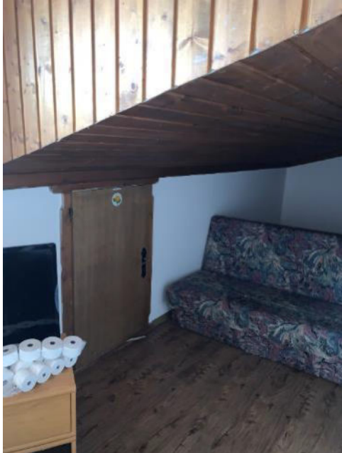
Bild 21 von 88 Blick auf eine Türe zum Dachraum
