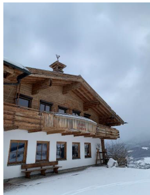
Bild 4 von 88 Ansicht aus Osten
