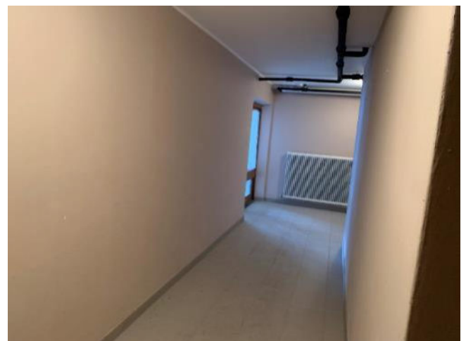
Bild 68 von 88 Blick in einen Kellerflur
