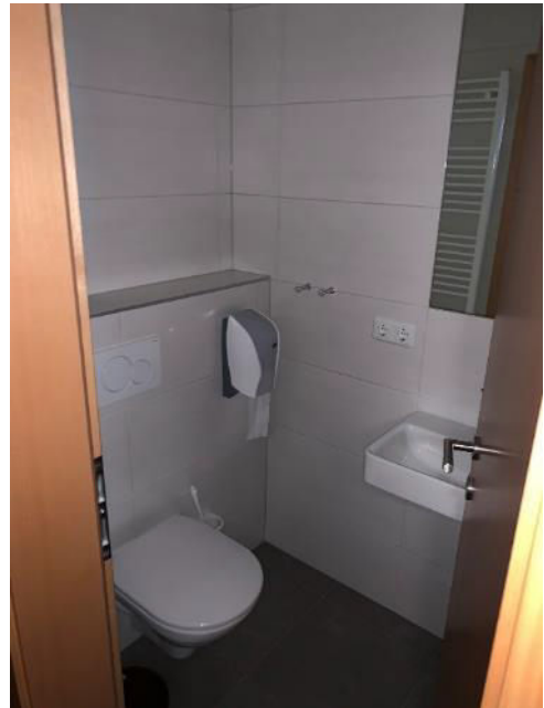
Bild 14 von 88 Blick in das Bad des Zimmers 402
