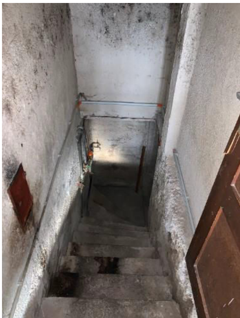
Bild 83 von 88 Blick in den Kellerabgang
