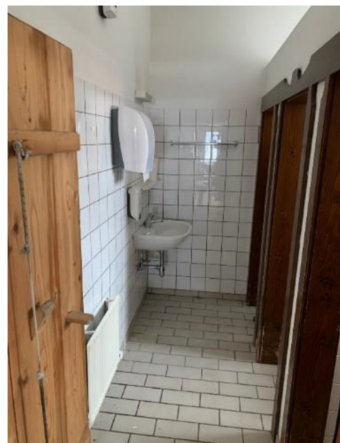
Bild 80 von 88 Blick in den Sanitärbereich
