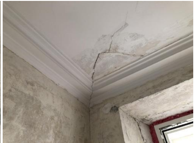
Bild 26 von 38 Blick auf die Deckenanbindung
