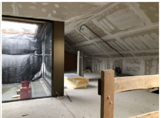
Bild 4 von 38 Blick in den künftigen Bürobereich
