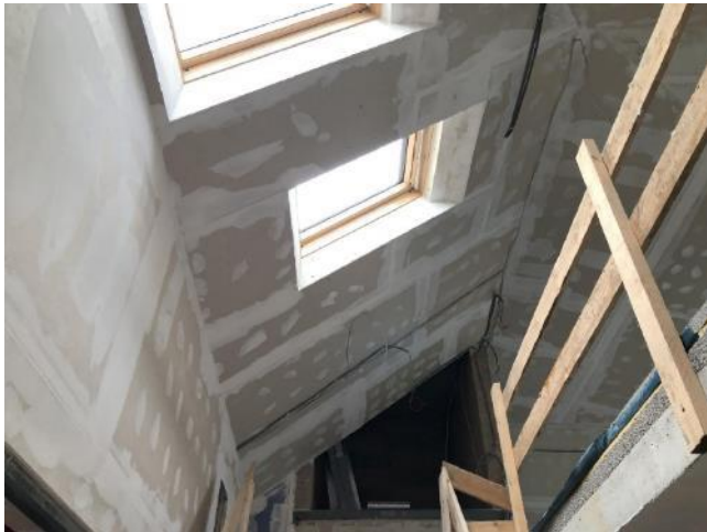
Bild 5 von 38 Blick auf die Dachuntersicht
