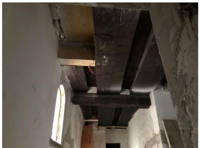
Bild 24 von 38 Blick auf eine Deckenkonstruktion
