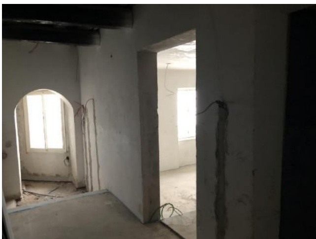
Bild 23 von 38 Blick in einen künftigen Zwischenflur
