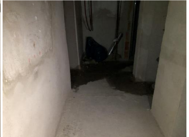
Bild 38 von 38 Blick in einen Kellerbereich
