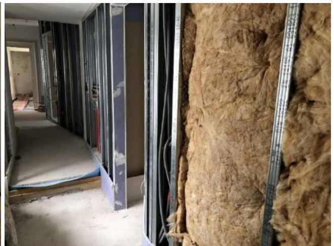
Bild 14 von 38 Blick in einen künftigen Flur
