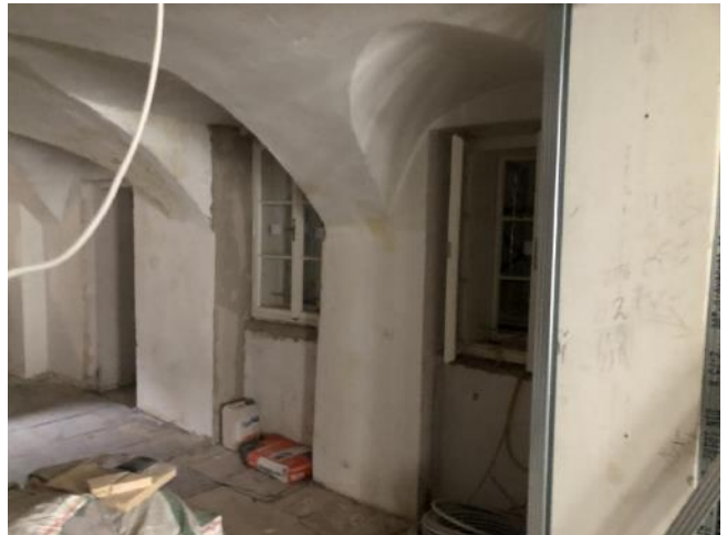
Bild 22 von 38 Blick in einen gewölbeartigen Raum
