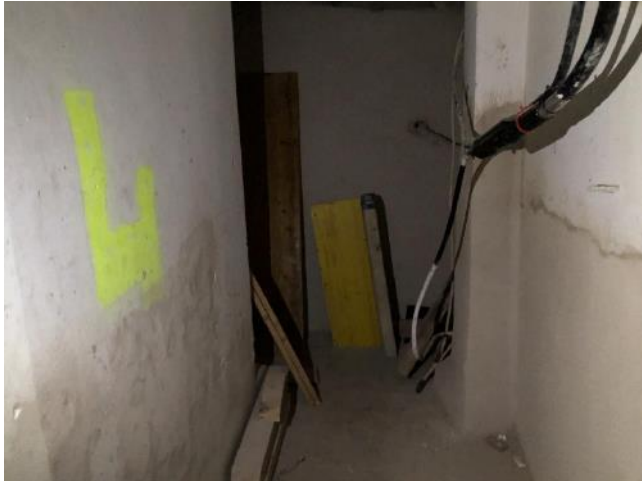
Bild 37 von 38 Blick in einen Kellerflur
