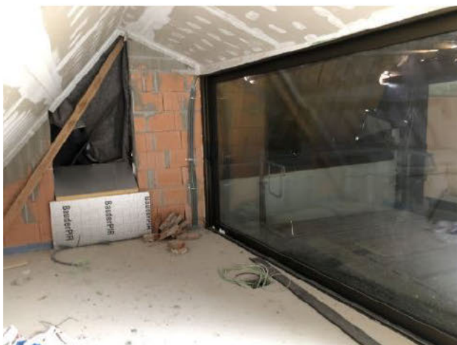
Bild 3 von 38 Blick in den künftigen Bürobereich
