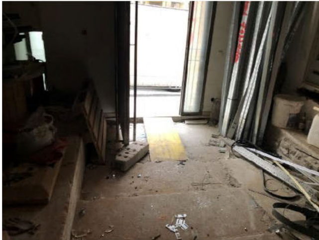
Bild 33 von 38 Blick in den Zugangsbereich
