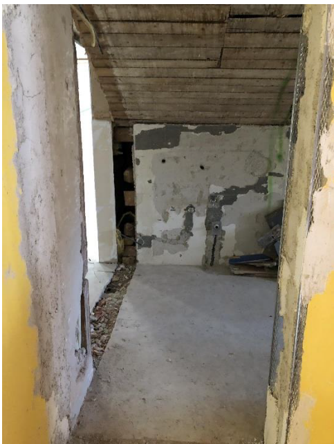
Bild 23 von 38 Blick in den Durchgang Richtung Anbaubereich
