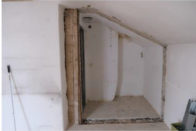
Rechts dem Kamin ist ein Wasserschaden an der Decke sichtbar:
