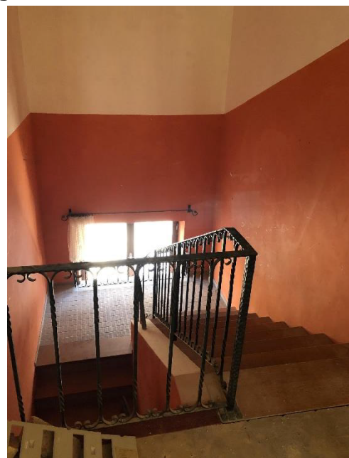
Bild 36 von 38 Blick in das interne Stiegenhaus (DG ins 1. OG)
