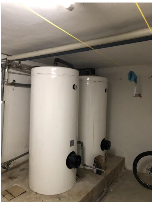
Bild 7 von 38 Blick in den allgemeinen Wasraum
