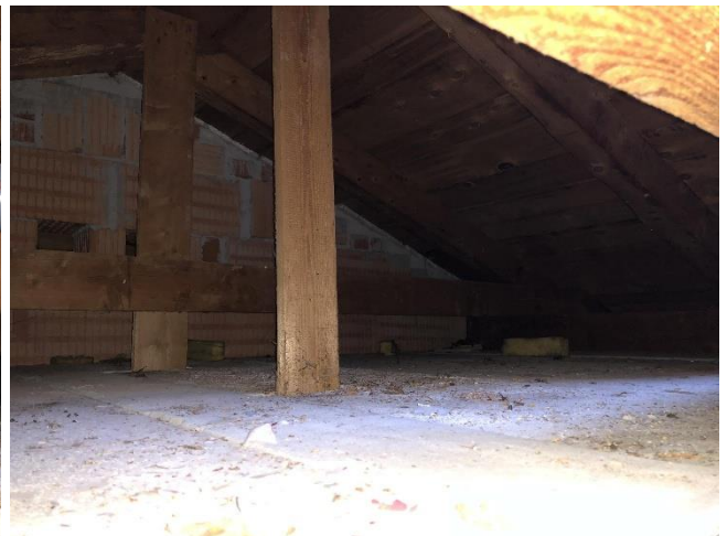
Bild 34 von 38 Blick in den Spitzboden
