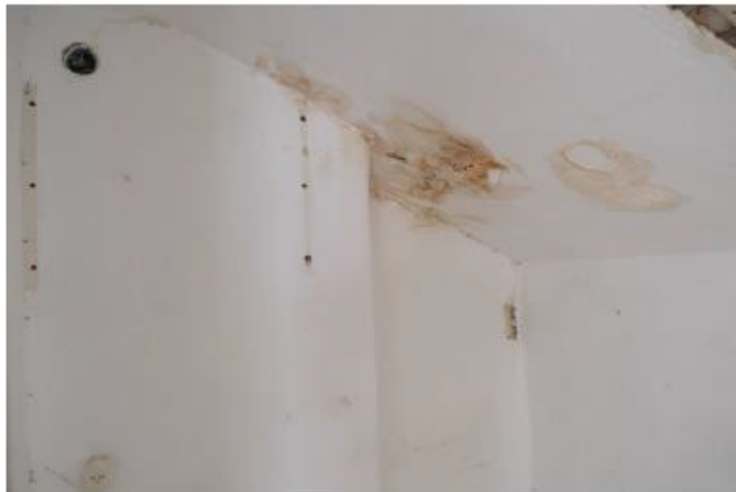
Rechts dem Kamin ist ein Wasserschaden an der Decke sichtbar:
