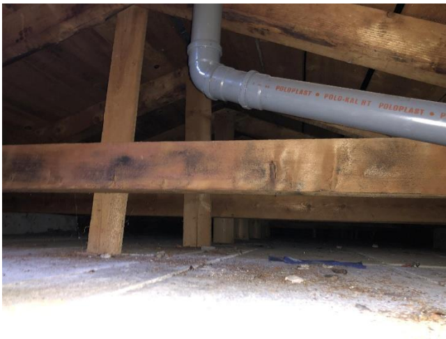
Bild 33 von 38 Blick in den Spitzboden
