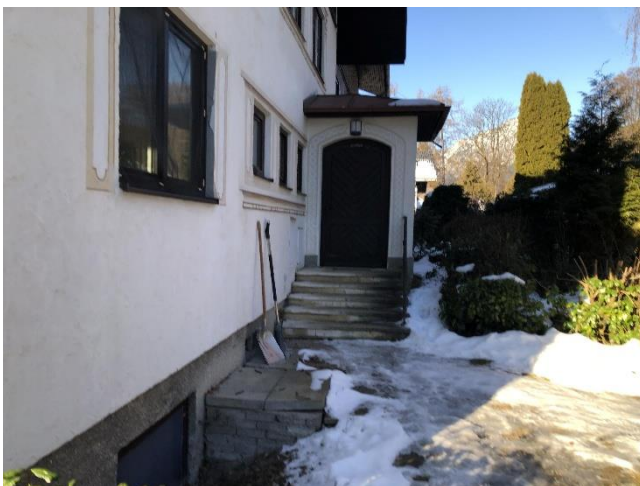
Bild 3 von 38 Blick auf den Eingangsbereich aus Südosten
