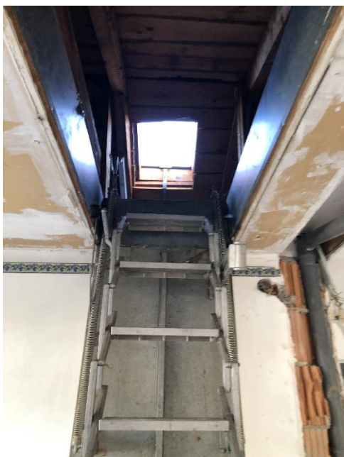
Bild 35 von 38 Blick in den Aufgang zum Spitzboden
