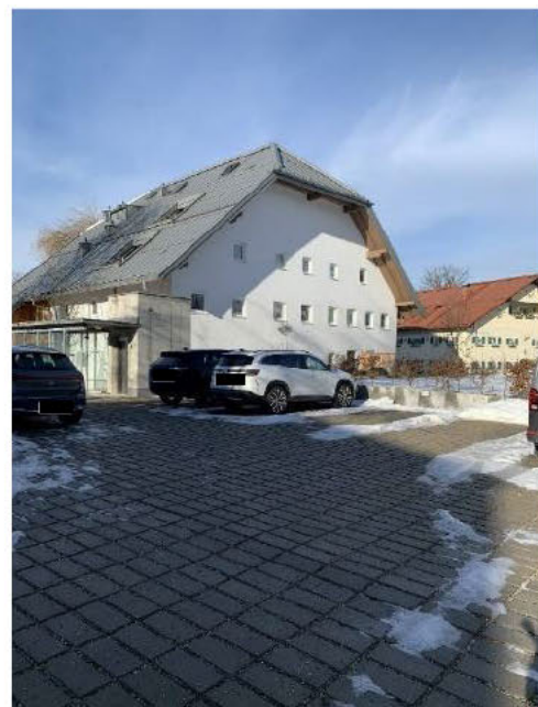
Bild 4 von 60 Ansicht aus Osten
