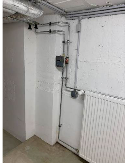
Bild 46 von 60 Blick in den Keller
