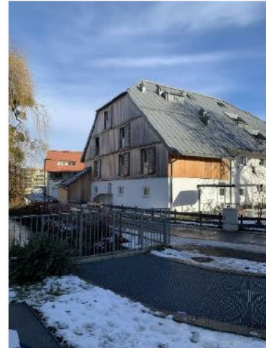
Bild 2 von 60 Ansicht aus Westen
