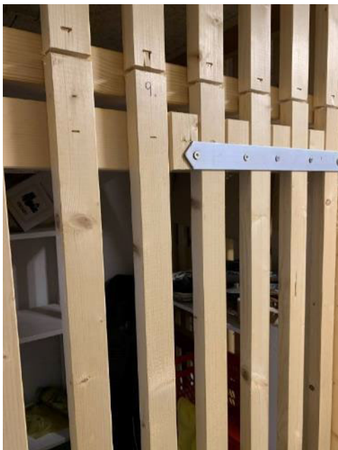
Bild 51 von 60 Blick auf das Kellerabteil KA 9
