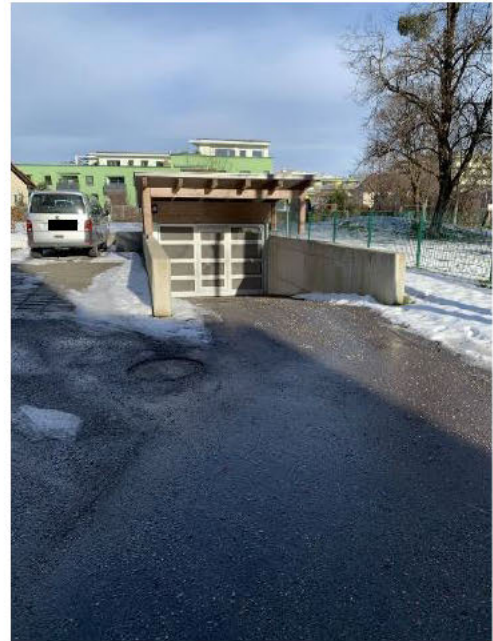
Bild 58 von 60 Blick auf die Tiefgaragenabfahrt
