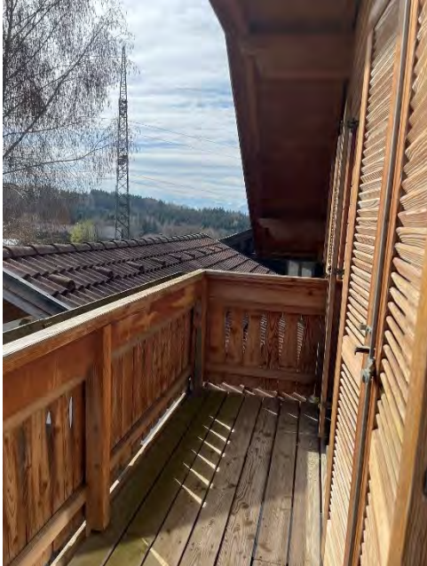
Bild 25 von 63 Blick auf den Balkon im Osten
