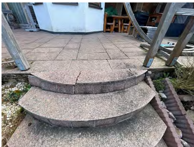
Bild 51 von 63 Blick auf die Stiege in Richtung Pool
