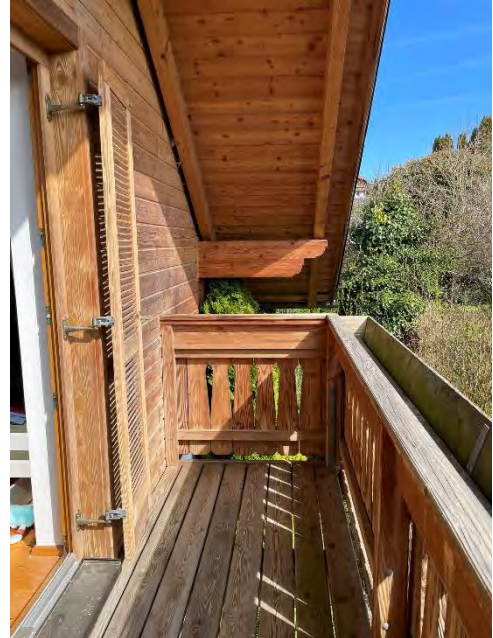
Bild 26 von 63 Blick auf den Balkon im Osten
