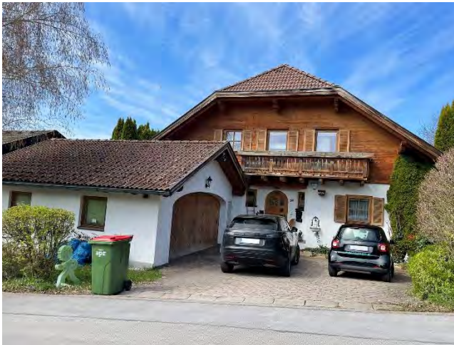
Bild 1 von 63 Ansicht aus Osten
