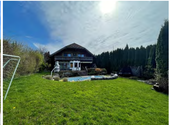
Bild 2 von 63 Ansicht aus Westen
