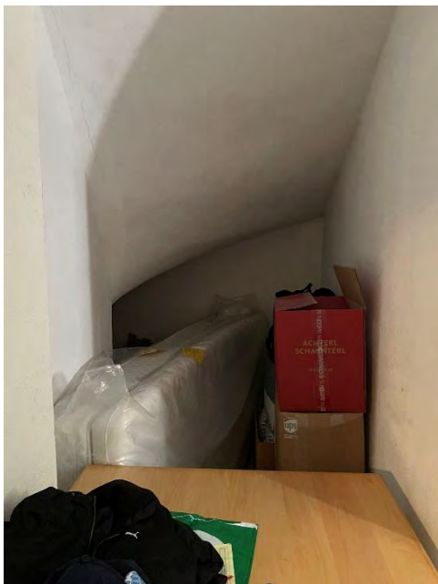
Bild 39 von 63 Blick unter die Stiege im Waschraum
