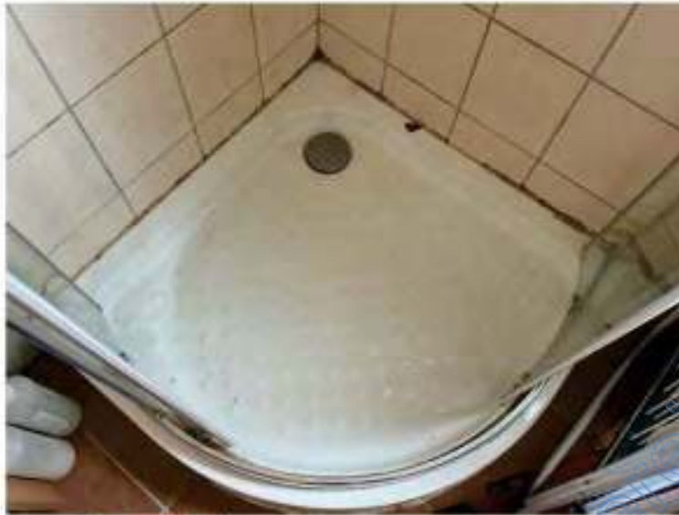
Bild 38: Feuchte- und Substanzschäden im Bereich der Duschtasse
