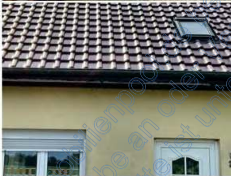
Bild 16: Feuchte- und Substanzschäden im Bereich der Traufverkleidung aus Holz
