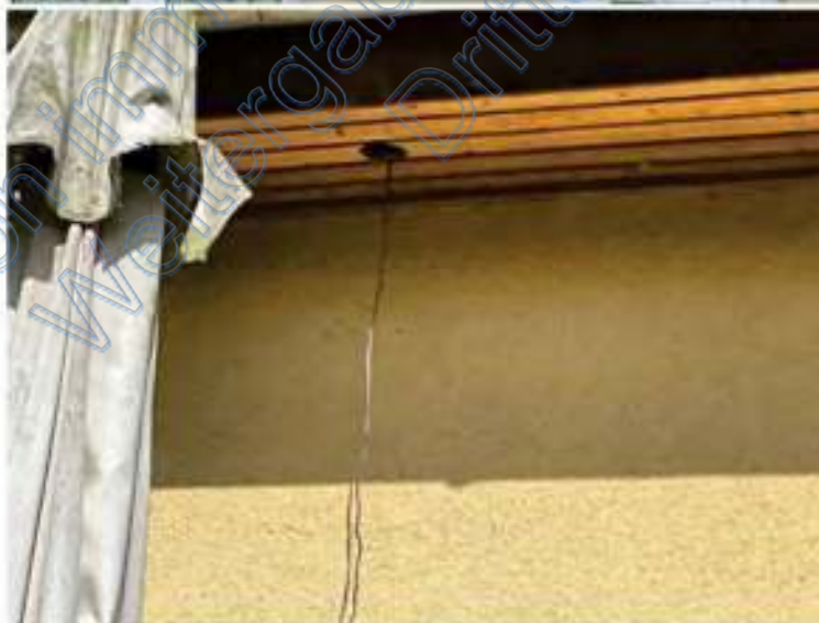
Bild 17: beispielhafte Beschädigung der Einbauleuchten im Dachkastenbereich
