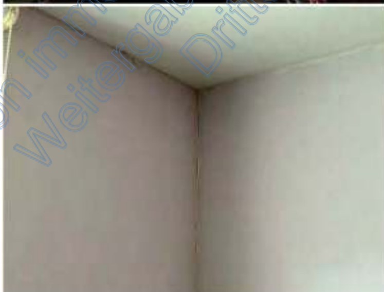
Bild 50: Rissbildung im Wand- und Deckenbereich
