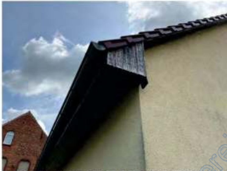
Bild 15: Feuchte- und Substanzschäden im Bereich der Traufverkleidung aus Holz
