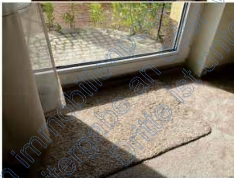
Bild 33: nicht fertiggestell- ter Anschluss Terrassentür
