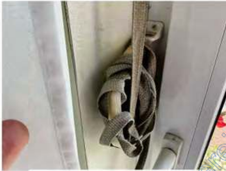
Bild 34: beschädigter Zuggurt Außenjalousie
