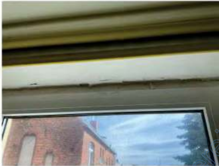
Bild 53: Feuchte- und Substanzschäden im Fensterlaibungsbereich
