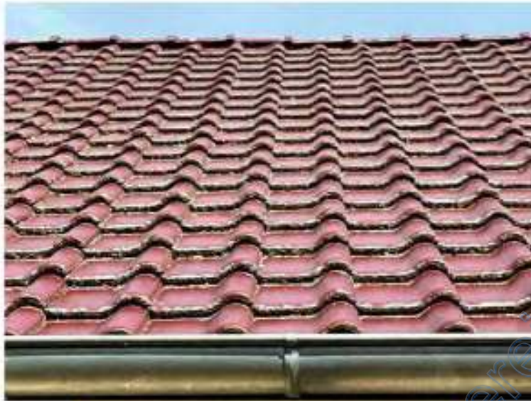
Bild 18: partielle Moosbildung im Bereich der Dachziegel
