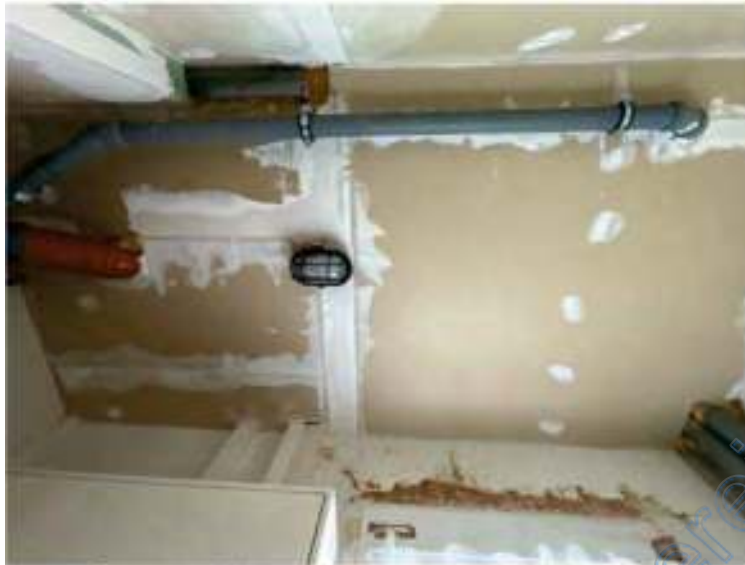
Bild 44: unfertige Wand-/ Deckenoberfläche
