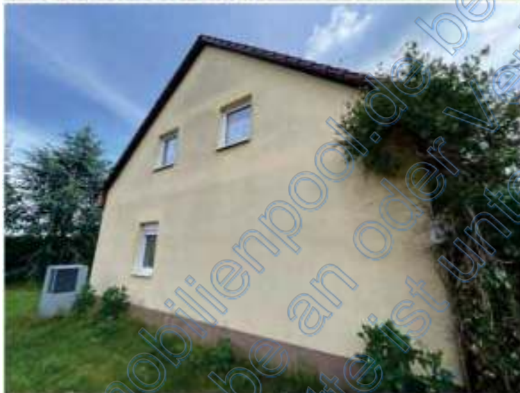
Bild 7: Einfamilienhaus (Giebelansicht) mit Algen- befall im Fassadenbereich
