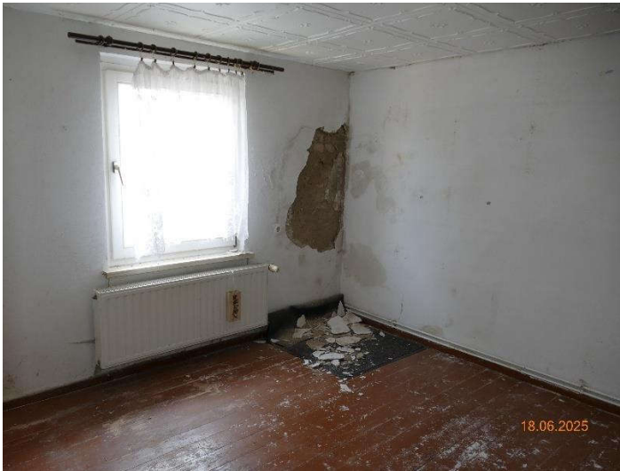
Feuchte-/Putzschäden Wohnraum (OG)
