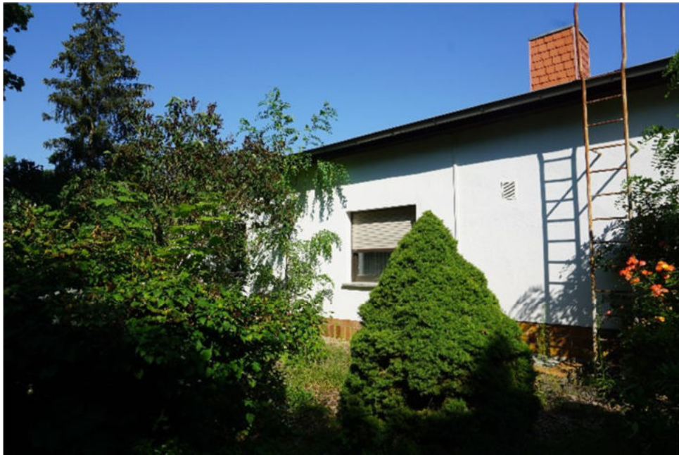
Bild 7: Ansicht aus südlicher Richtung
