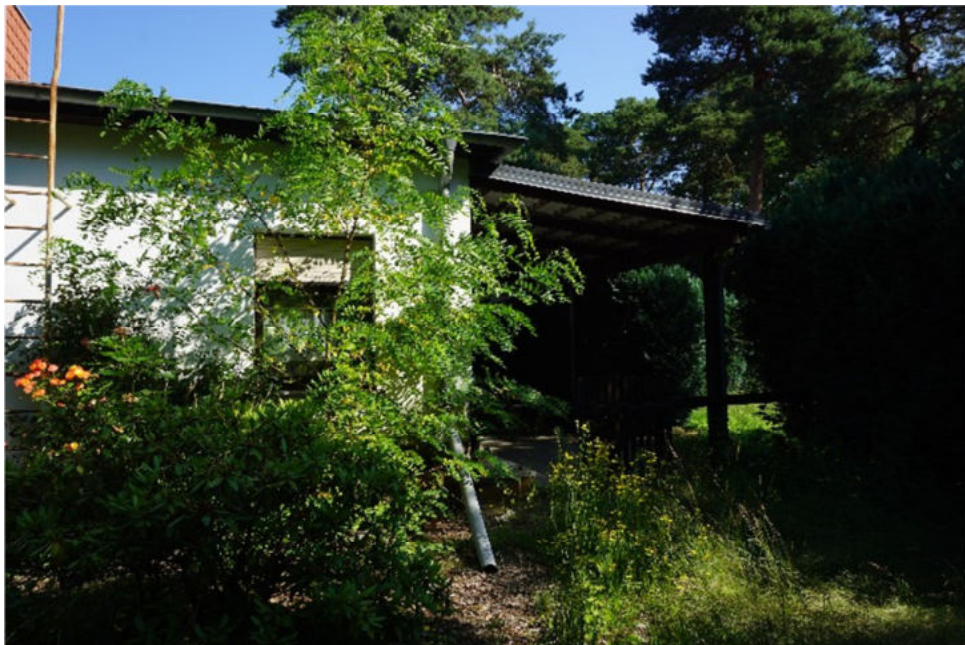
Bild 8: Ansicht aus südlicher Richtung
