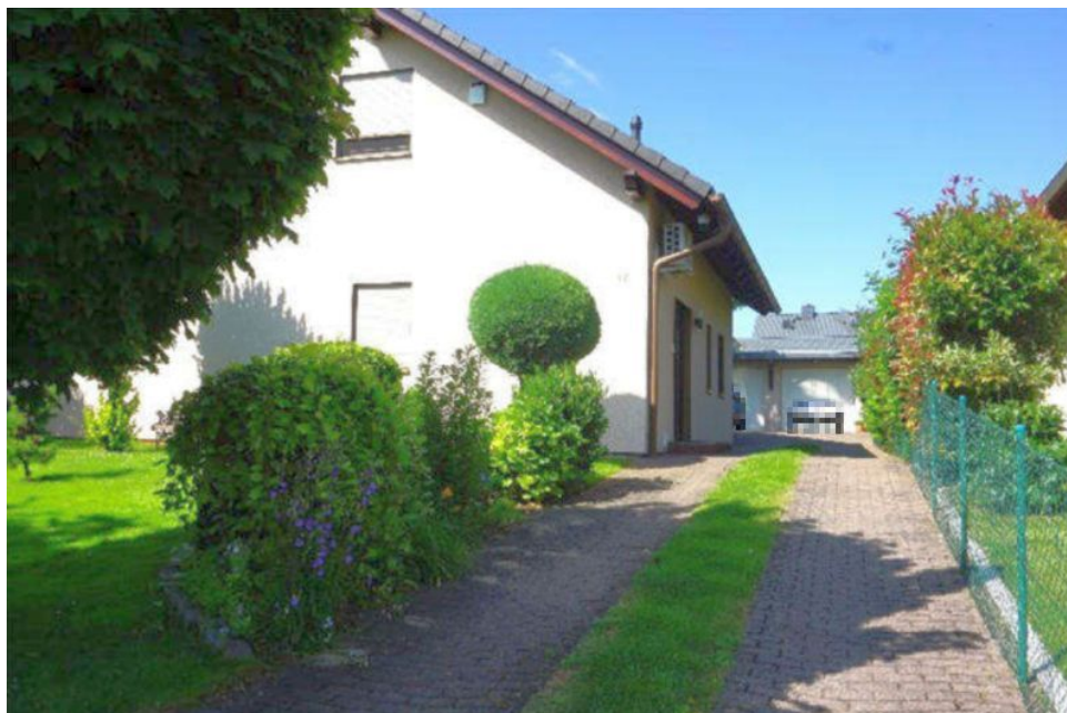
Bild 4: Vorderansicht des Einfamilienhauses und der Doppelgarage
