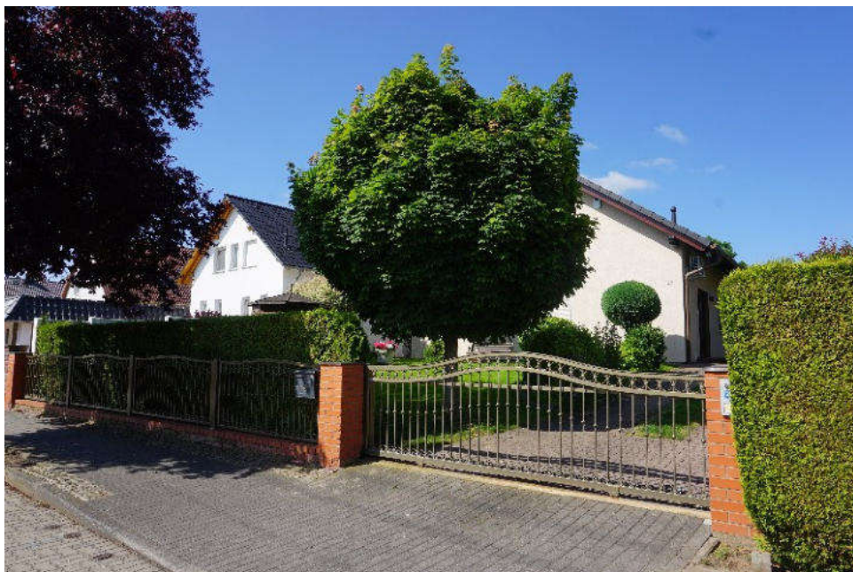
Bild 8: Straßenansicht des Bewertungsobjekts aus nordöstlicher Richtung
