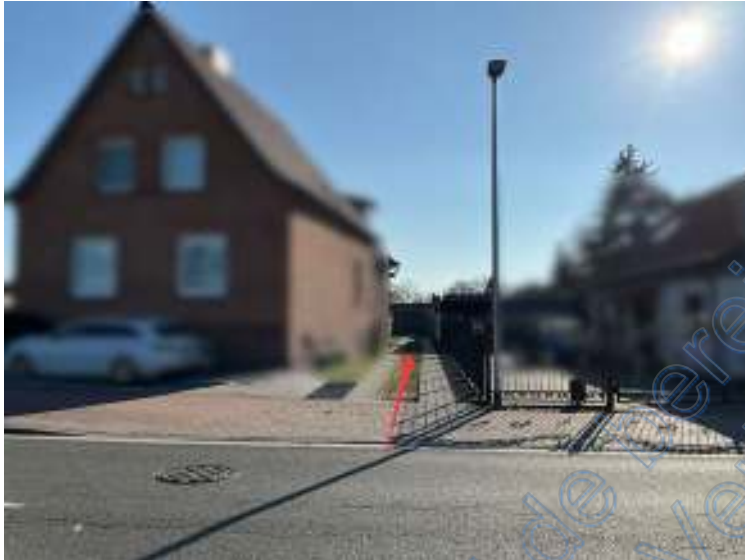
Bild 1: Zufahrt zum Grundstück von der „Magdeburger Straße“ über Privatgrundstück (Straßenansicht)
