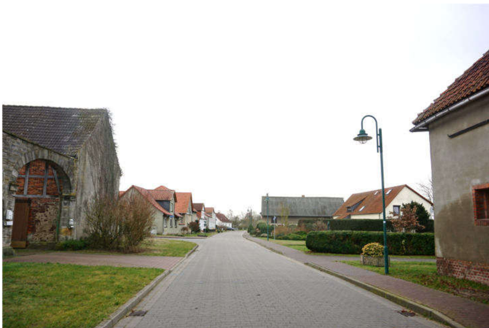
Bild 8: Dorfstraße in südlicher Richtung
