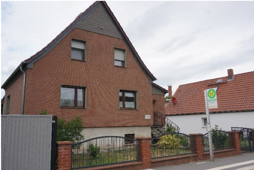
Bild 1: Straßenansicht des Bewertungsobjekts aus südwestlicher Richtung
