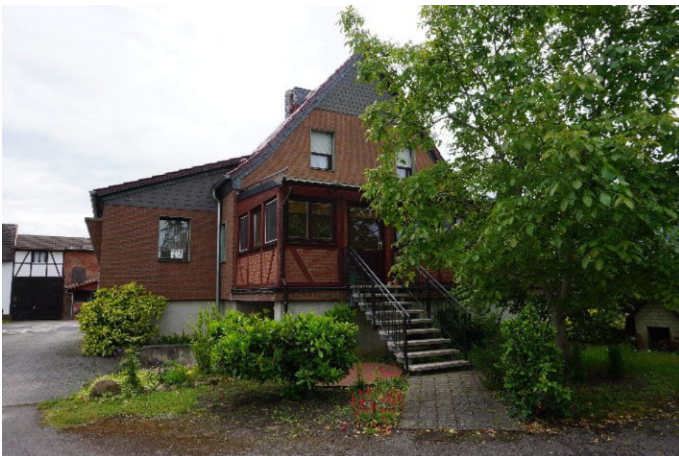
Bild 10: Gartenansicht des Einfamilienhauses
