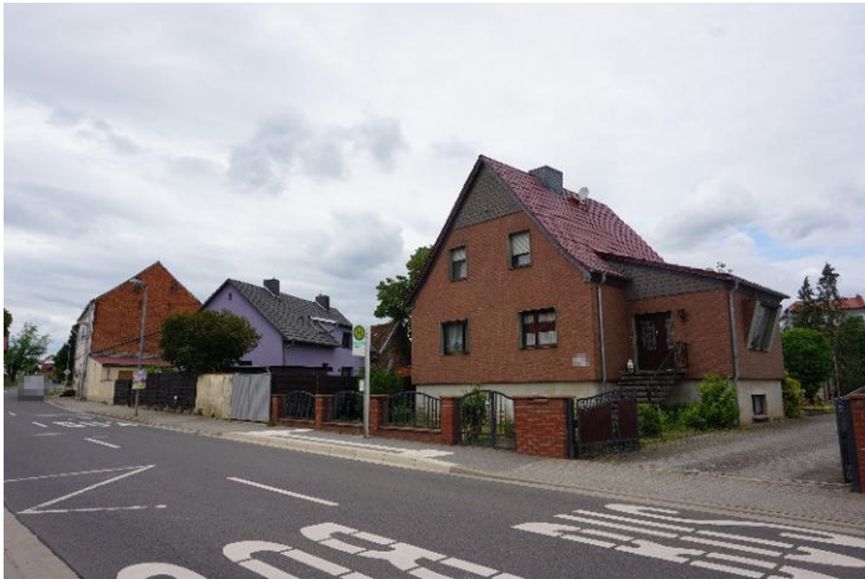
Bild 15: Nachbarschaft und Umfeld in westlicher Richtung
