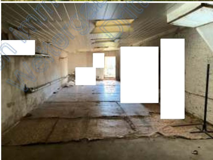
**Bild 20:** Garage mit Feuchte- und Substanzschäden im Decken-/Dachbereich
