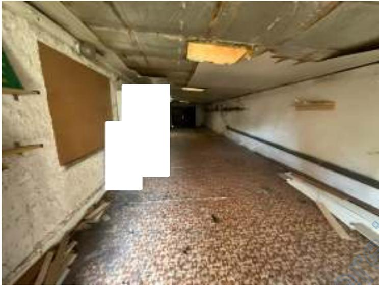
**Bild 21:** Garage mit Feuchte- und Substanzschäden im Decken-/Dachbereich
