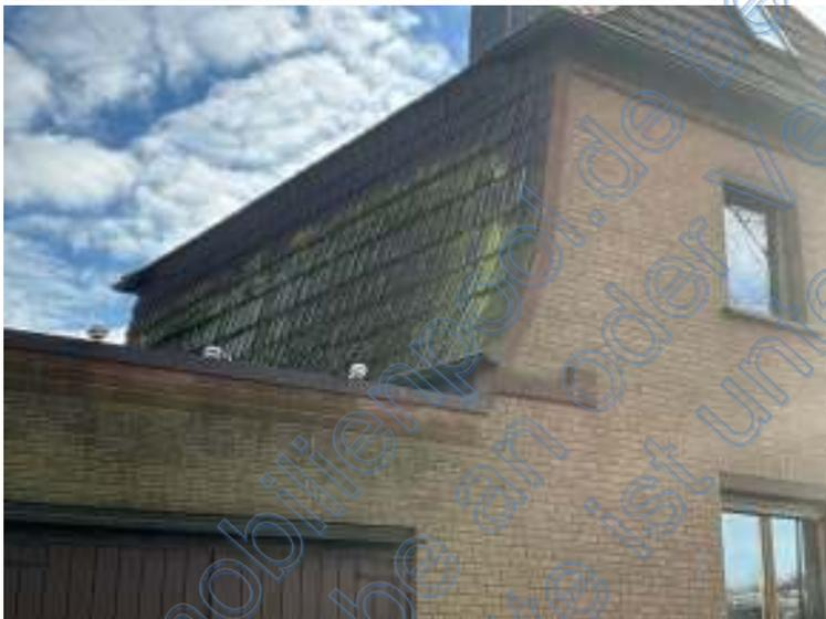
**Bild 4:** Algen- und Moosbefall im Fassaden und Dachbereich
