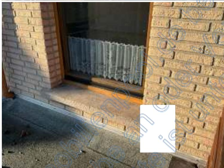
**Bild 45:** Feuchte- und Substanzschäden im Fensterbereich
