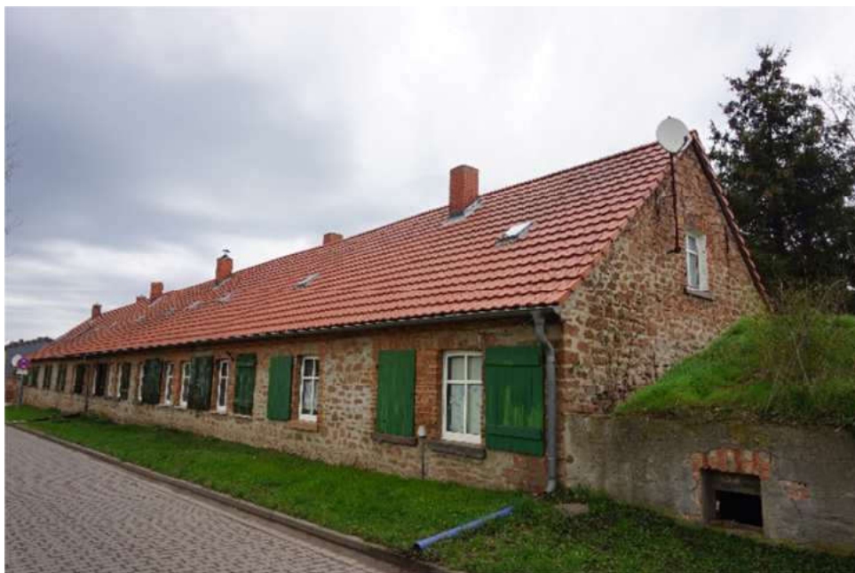
Bild 4: Straßenansicht Gebäude "Am Sportplatz 14,15,16,17"
