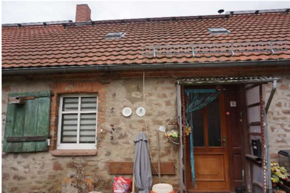
Bild 15: Gebäude "Am Sportplatz 14,15,16,17" mit einzelnen Wohnungseingängen
