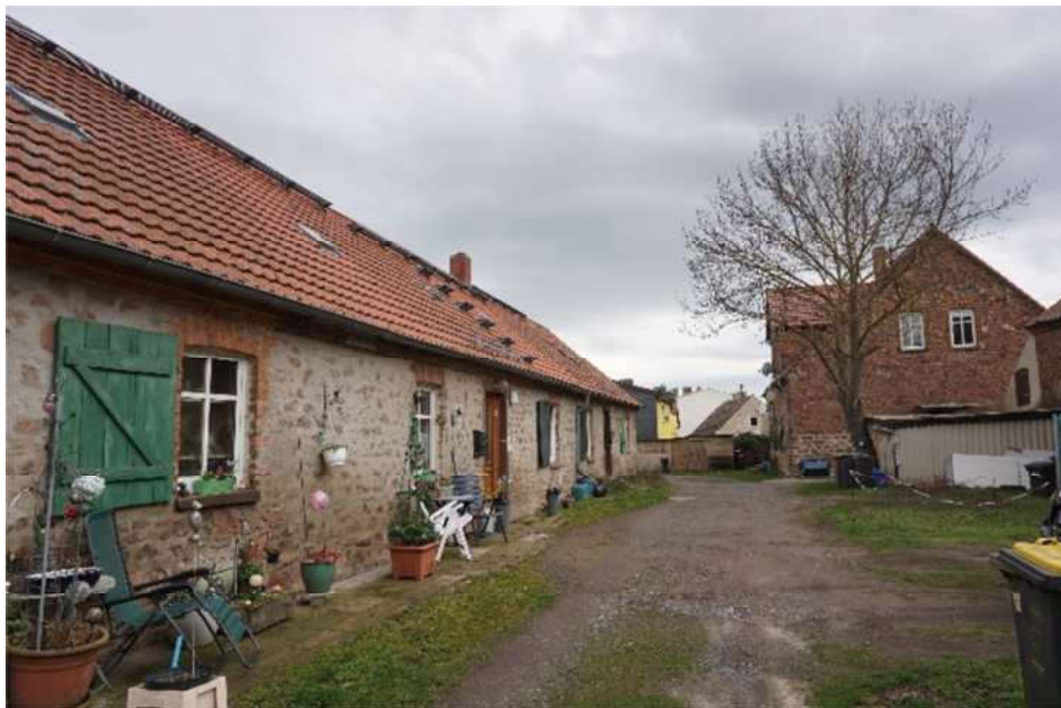
Bild 14: Gebäude "Am Sportplatz 14,15,16,17" mit einzelnen Wohnungseingängen
