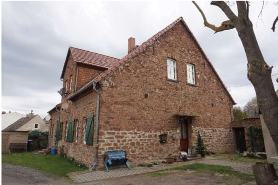
Bild 7: Giebelansicht Gebäude "Am Sportplatz 12"
