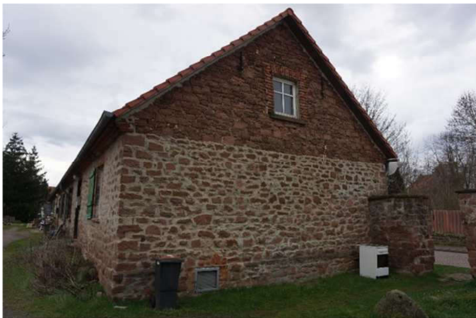
Bild 11: Giebelansicht Gebäude "Am Sportplatz 14,15,16,17"
