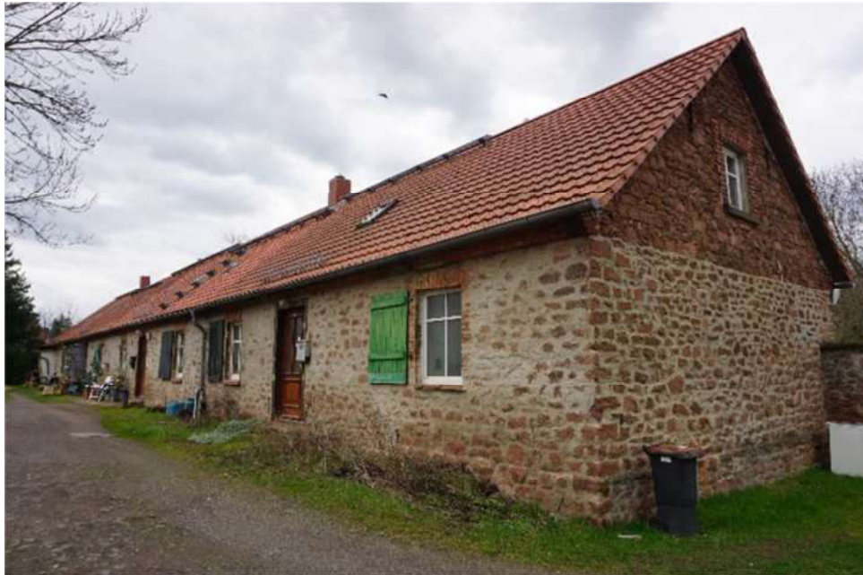
Bild 12: Rückansicht Gebäude "Am Sportplatz 14,15,16,17"
