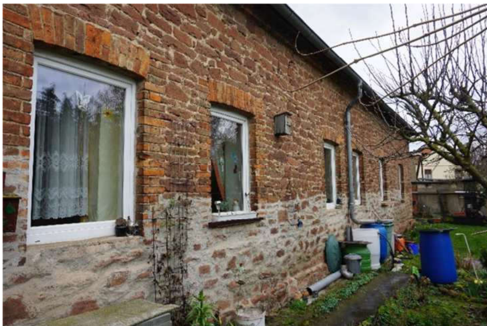
Bild 16: Gebäude "Am Sportplatz 14,15,16,17"
