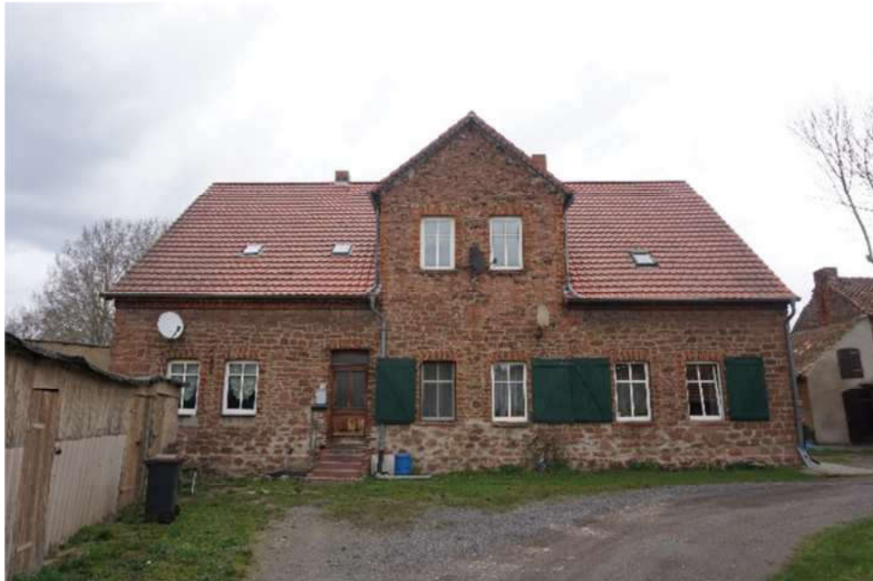
Bild 5: Vorderansicht Gebäude "Am Sportplatz 12"
