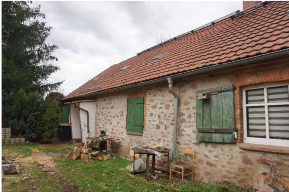
Bild 13: Gebäude "Am Sportplatz 14,15,16,17" mit einzelnen Wohnungseingängen
