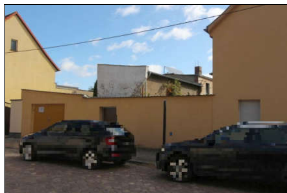
Ansicht des Bewertungsobjektes von der Schloßstraße aus
