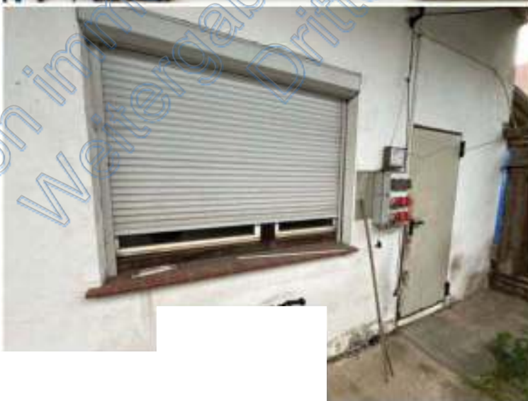
Bild 17: Zugang Werkstattbereich (EG) sowie Feuchte- und Substanzschäden im Fassadenbereich
