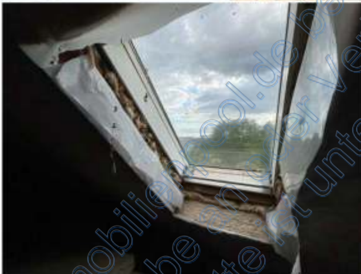
Bild 63: mangelhafte Ausführung der Dampfbremse
