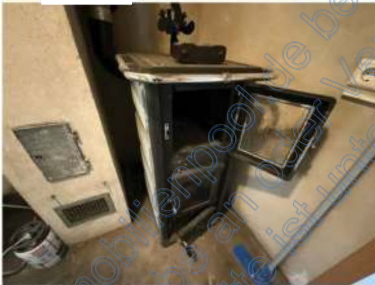
Bild 41: Festbrennstoffkessel
