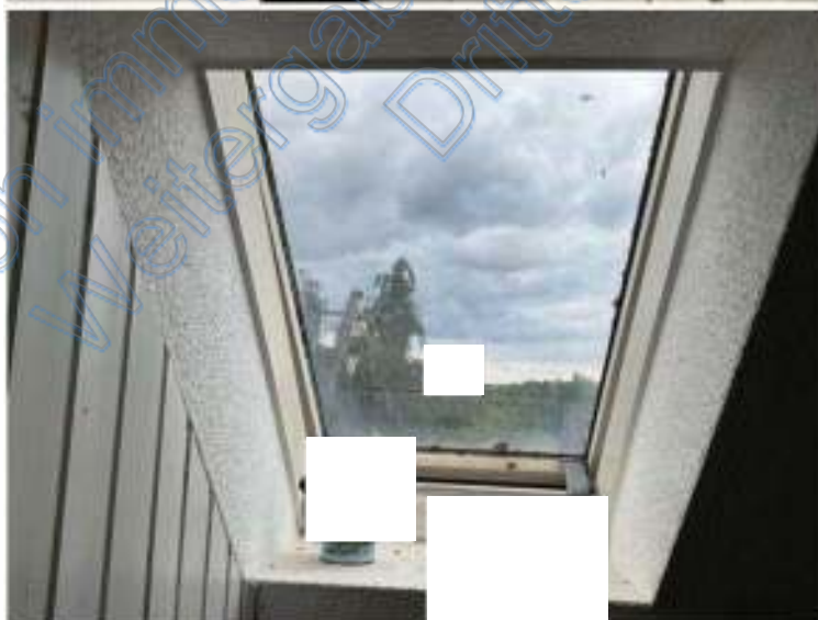
Bild 51: Dachflächenfenster mit beginnenden Feuchte- und Substanzschäden
