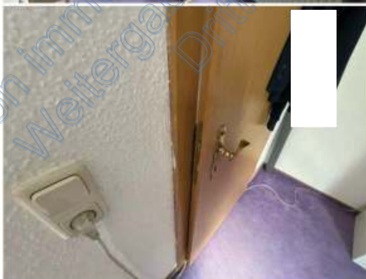
Bild 54: mangelhafter Anschlussbereich in der Tür-laibung
