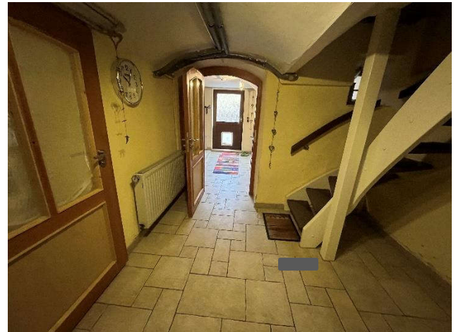
Keller mit Blick in Richtung Eingangsvorbau sowie Treppe in das EG
