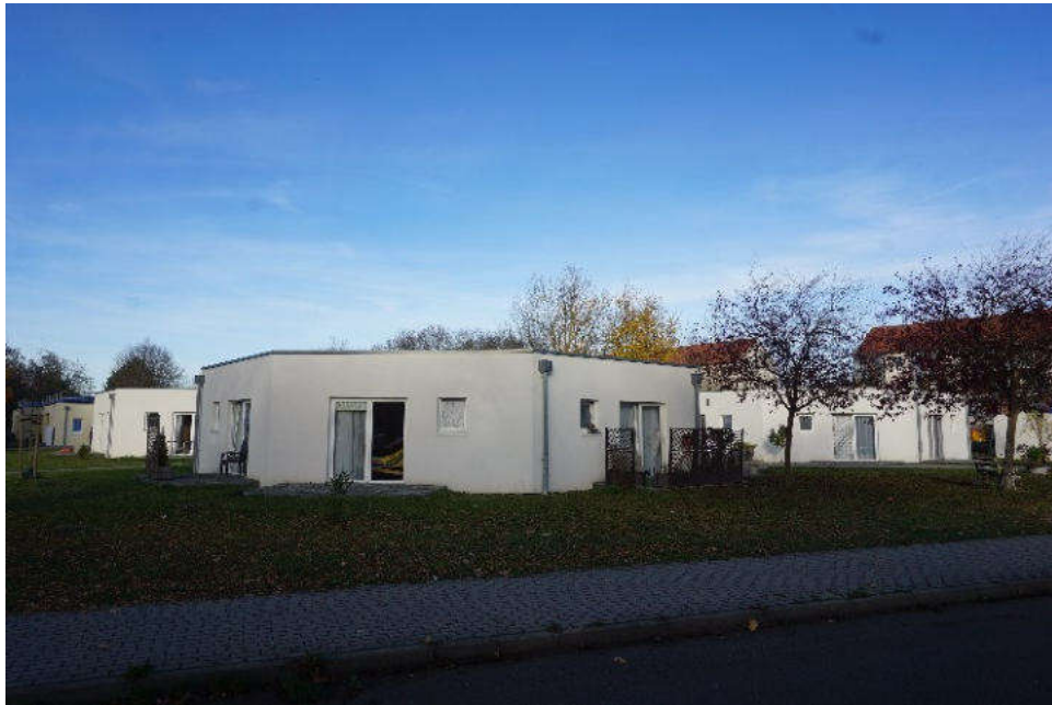
Bild 3: Straßenansicht des Bewertungsgrundstücks aus südwestlicher Richtung
