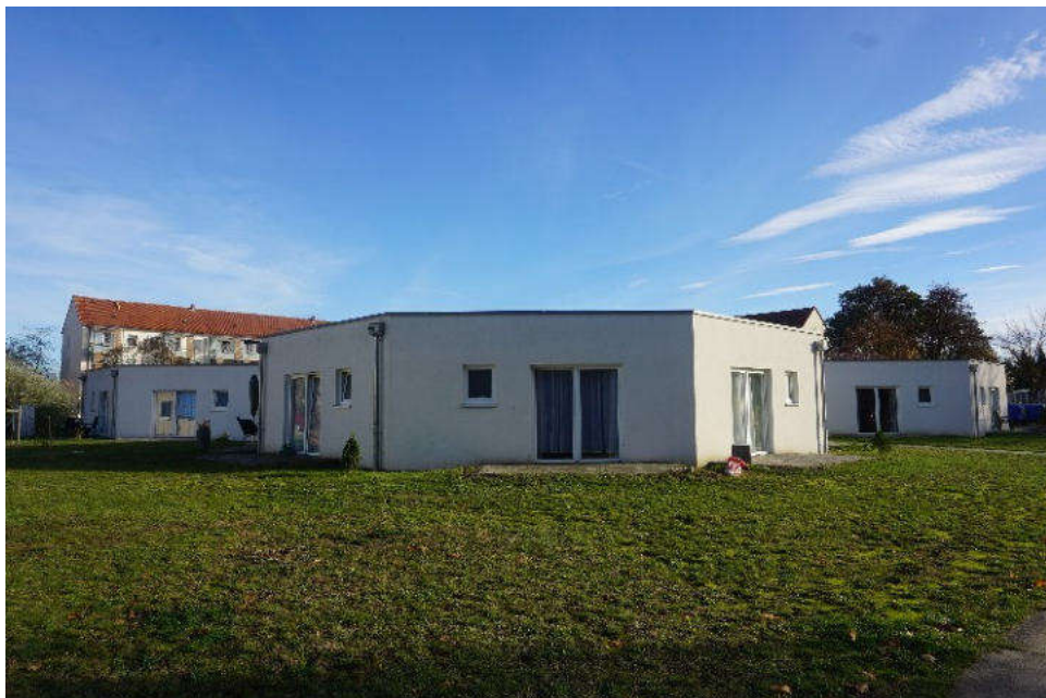
Bild 4: Straßenansicht des Bewertungsgrundstücks aus westlicher Richtung
