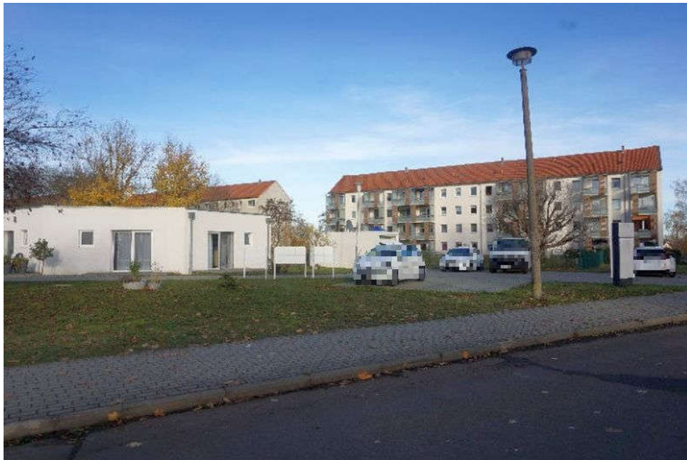
Bild 1: Straßenansicht des Bewertungsgrundstücks aus südwestlicher Richtung
