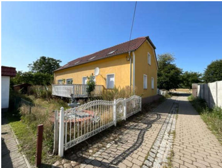
Bild 2: Einfamilienhaus mit Terrasse (Straßenansicht)
