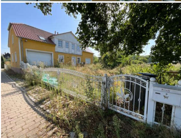
Bild 10: Grundstückszugang und -zufahrt
