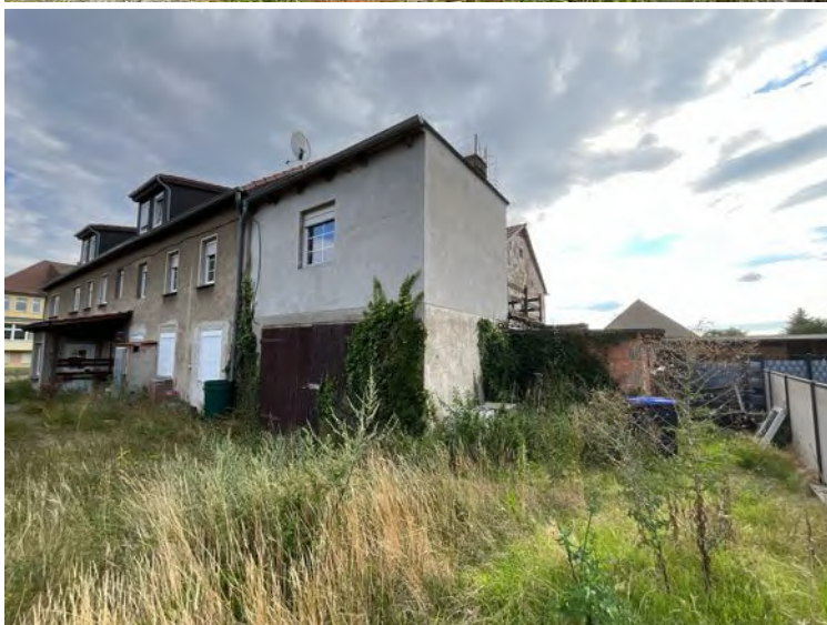
Bild 8: rückwärtige Ansicht des Mehrfamilienhauses mit Garage und Anbau
