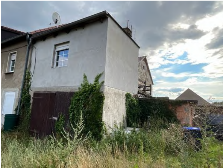
Bild 9: Garage und rückwärtiger Anbau
