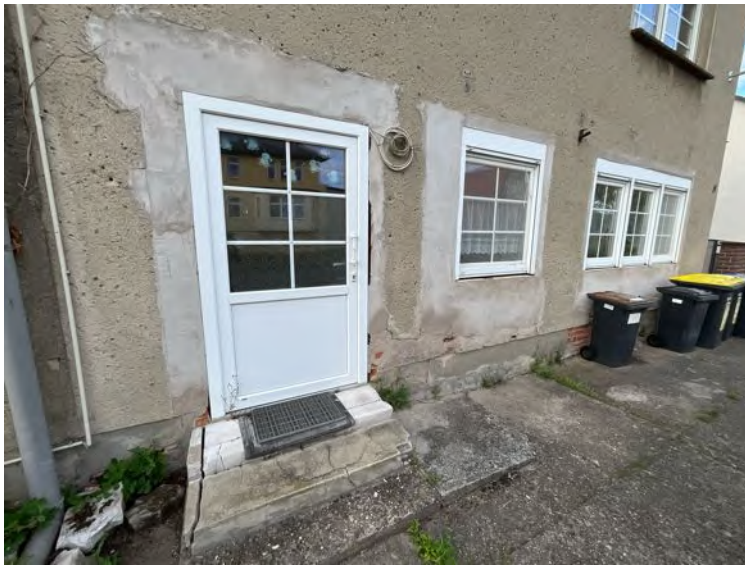
Bild 3: Eingangsbereich Wohnung (EG)
