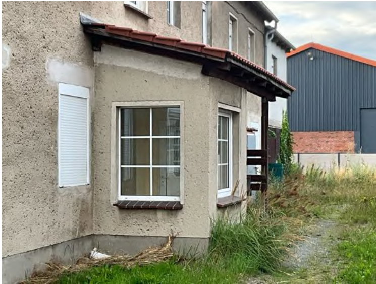
Bild 6: Eingangsbereich zum Treppenhaus für Wohnungen im Ober- und Dachgeschoss
