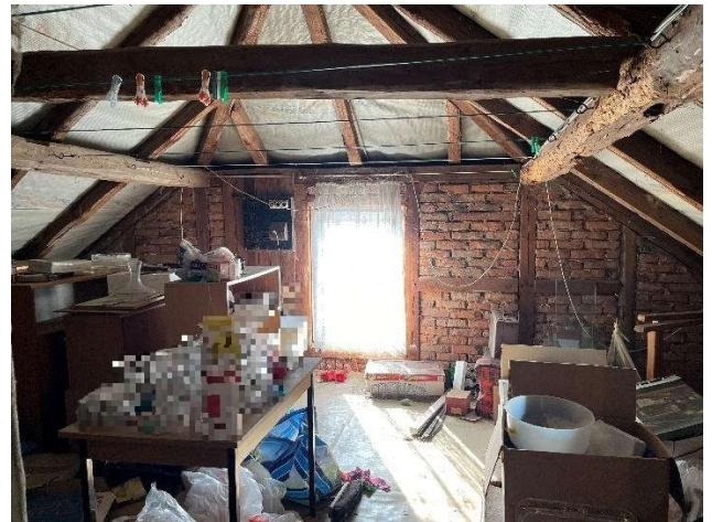
nicht ausgebautes DG
