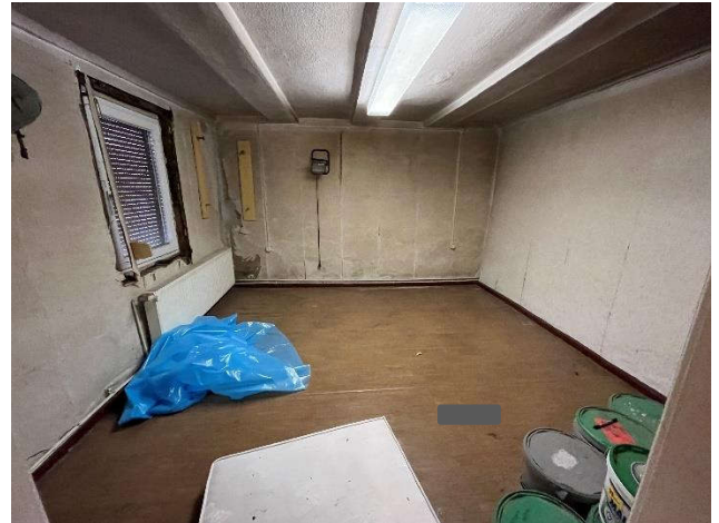
nicht ausgebautes Zimmer im EG
