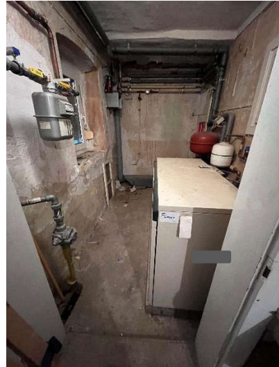
Abstellraum mit Heizung hinter der Küche
