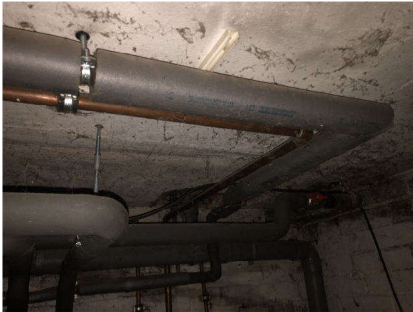
Bild 29: Dämmung der Heizungsleitungen im Kellergeschoss
