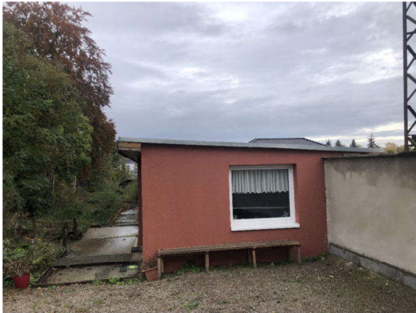
Bild 37: Nebengebäude aus südlicher Richtung
