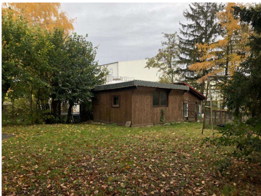
Bild 34: Gartenflächen und Gartenhaus (dahinter das Gelände der Brauerei)
