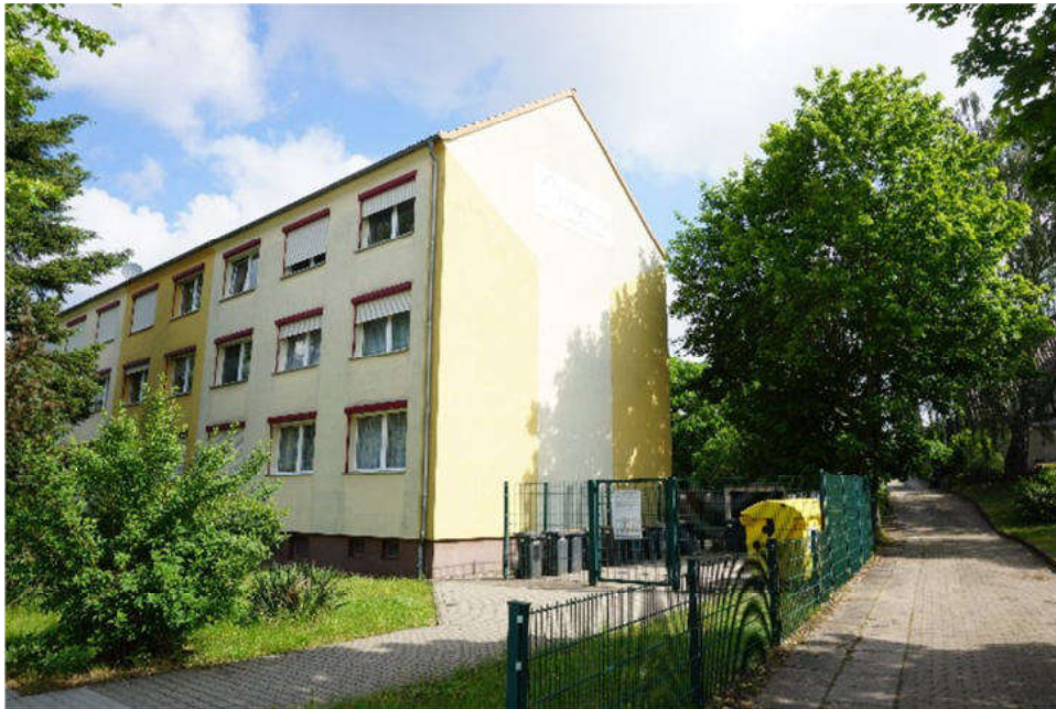
Bild 45: Nachbarschaft und Umfeld an der Wolmirstedter Straße und Zufahrtsweg zum Bewertungsgrundstück
