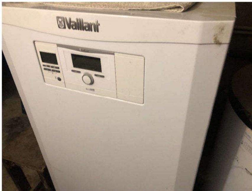
Bild 27: Gas-Brennwerttherme
