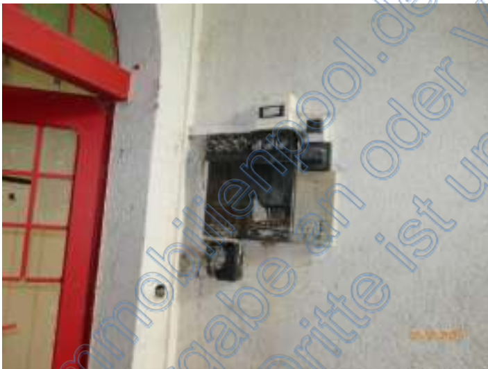
schadhafte Elektroinstallation
