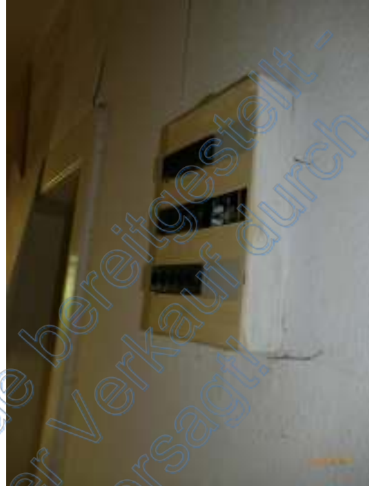
veraltete nicht funktionsfähige Elt.installation
