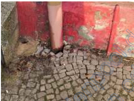
Defekter Bodeneinlauf des Fallrohres
