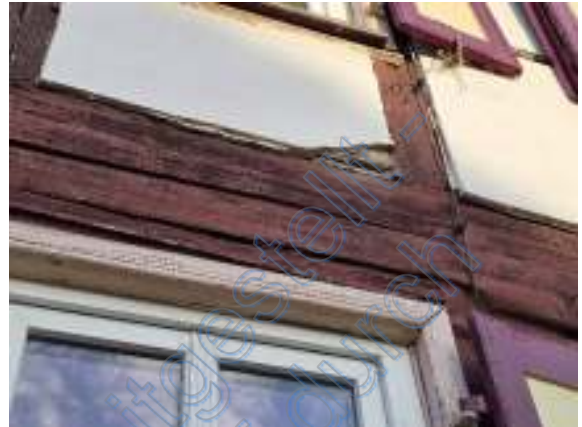
Putzabplatzung an der Ausfachung
