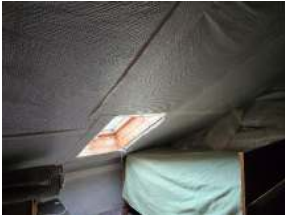
Unterspannbahn – Anbringung nicht normgerecht
