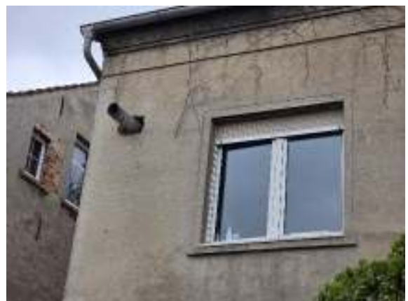
Durchbruch in der Rückwand
